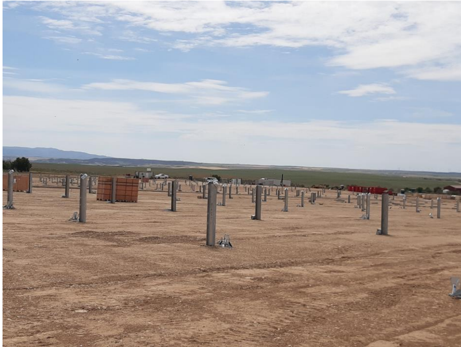
Fig. 1 Vista de situación actual de la parcela con hincas instaladas
