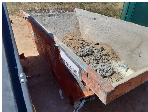
Fig. 2 Contenedor residuos de hormigón en correcto estado
