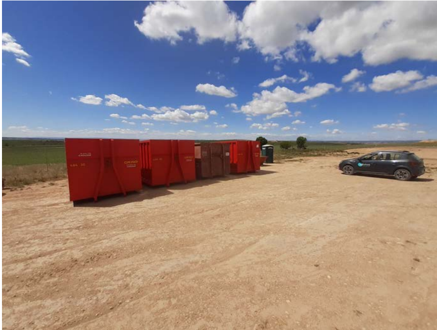
Fig. 1 Contenedores en zona de obras
