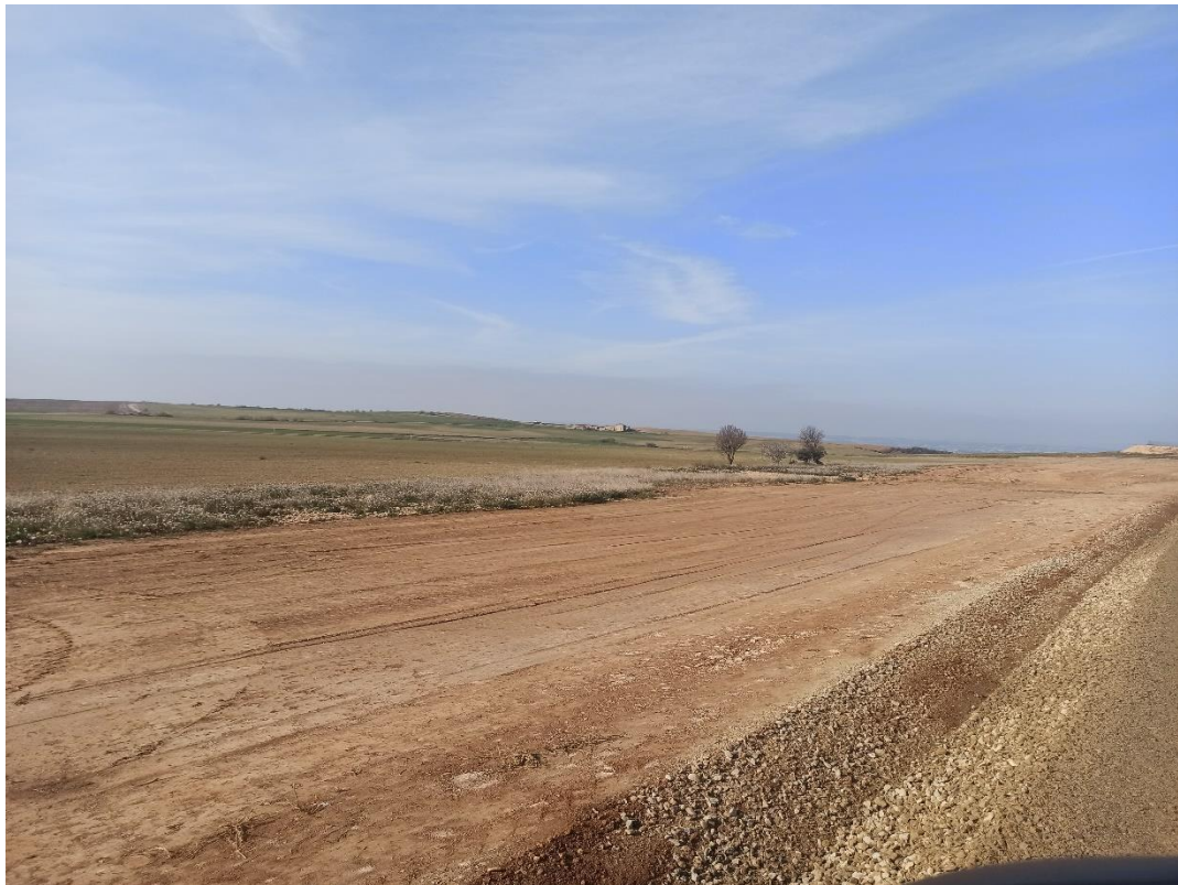
Fig. 1 Zona de tierra vegetal compactada
