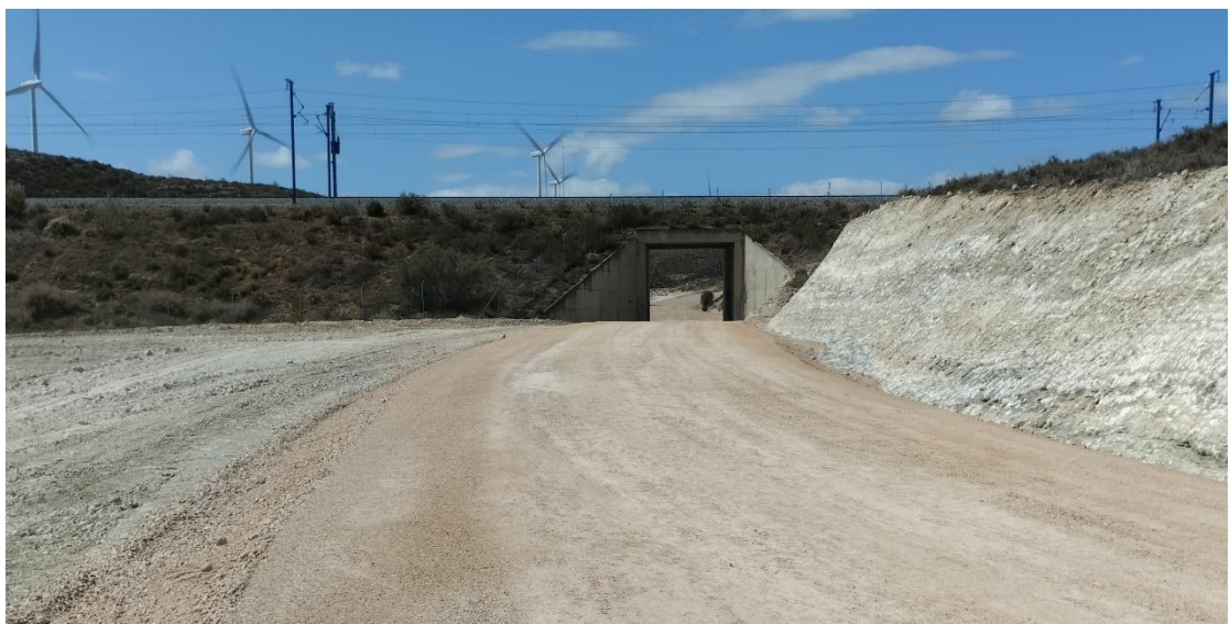
Tramo de zanja de acceso a la SET, sector anterior al cruce bajo el AVE: reparado y restaurado.
