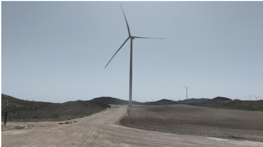
Plataforma y entorno del ACS 03. Ya se restauraron los terraplenes afectados por la tormenta.
