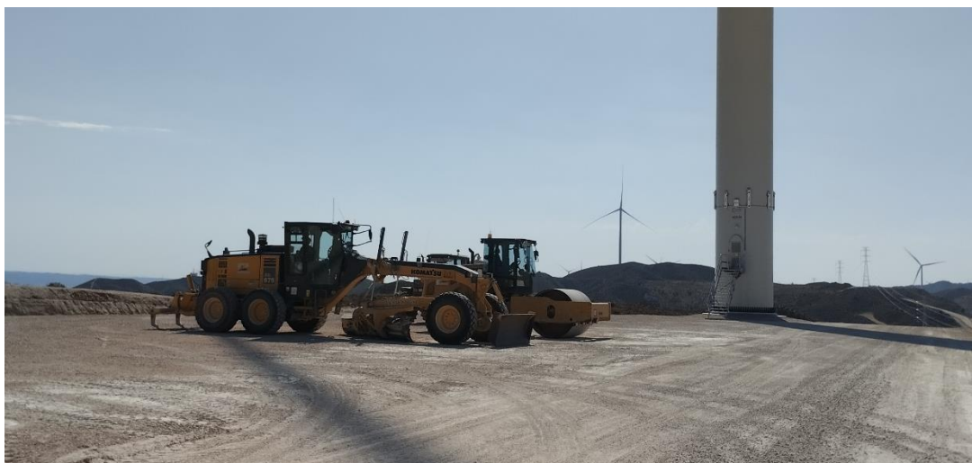
Detalle de la plataforma del ACS 04: aún no se han llevado las máquinas que realizaron los últimos trabajos.
