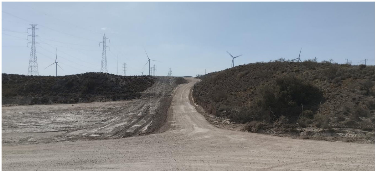
Plataforma del ACS 02: aquí se acopian tierras que serán empleadas en el relleno de la zona de giro adyacente al ACS 01
