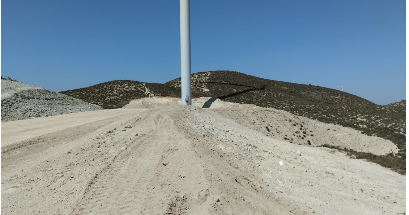
Plataforma del ACS 05: desmantelada la plataforma auxiliar, que ha pasado a ser un terraplén que da continuidad al de la plataforma permanente de servicio.
