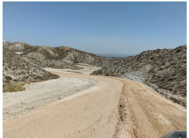
Camino 4, en el sector en el que se están realizando últimos repasos de extendido y compactado de zahorras
