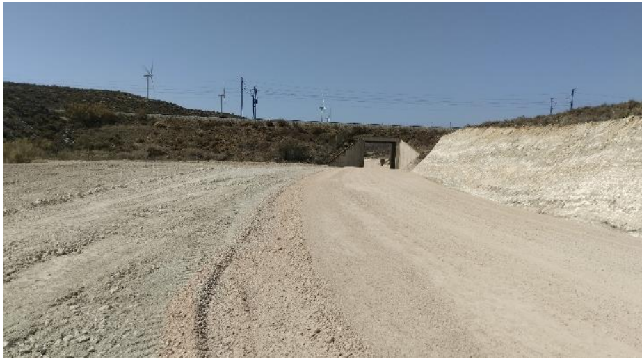
Tramo de zanja de conexión con la SET, sector anterior al cruce bajo el AVE.
