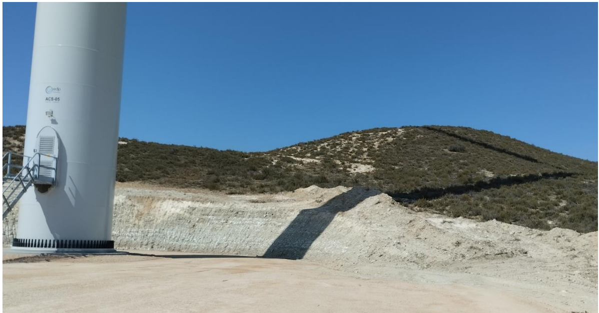
Extremo de la plataforma del ACS 05, en donde quedan algunos montones de tierra que extender.
