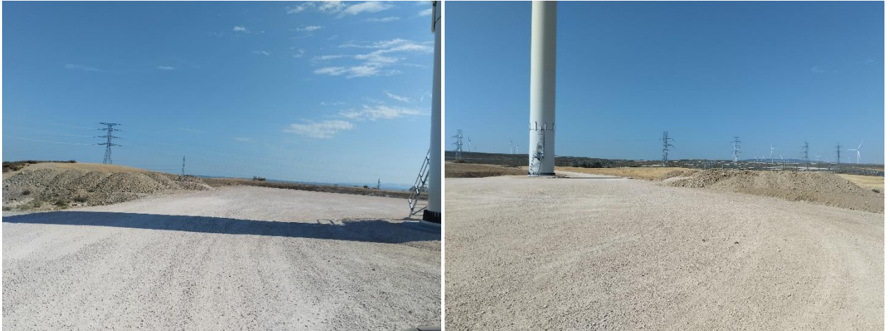
Plataforma del ACS 02: aquí se acopian tierras que serán empleadas en el relleno de la zona de giro adyacente al ACS 01
