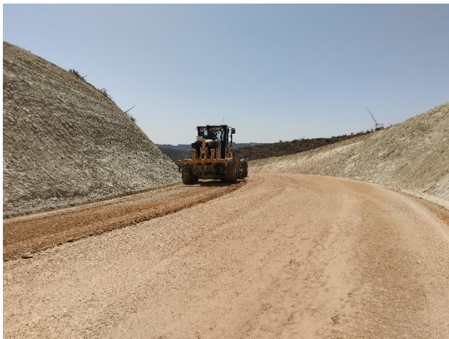
Camino 4, en el sector en el que se están realizando últimos repasos de extendido y compactado de zahorras
