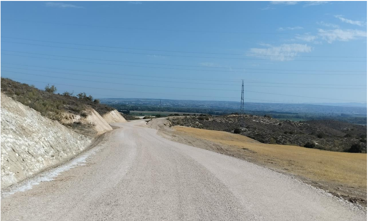
Vial de acceso a los aerogeneradores ACS 01 y ACS 02.
