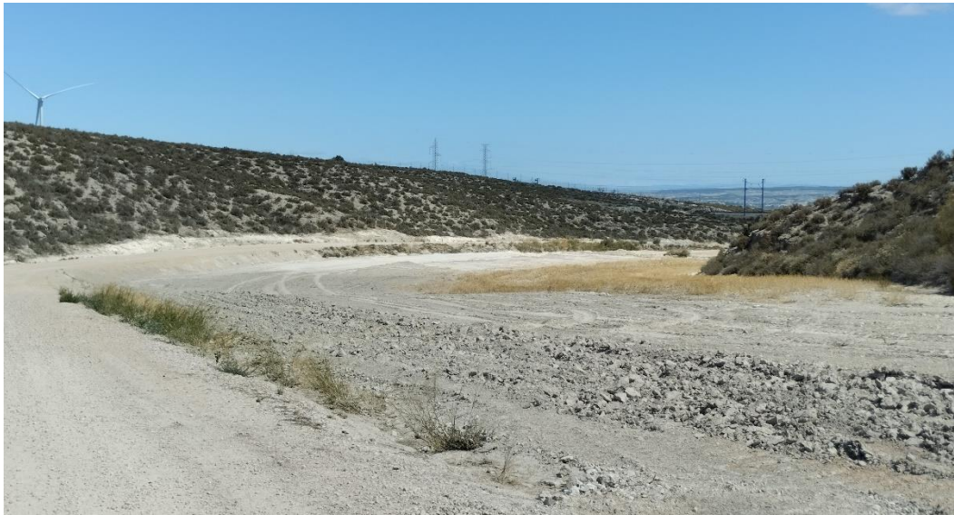
Tramo de zanja de acceso a la SET, tras el cruce bajo el AVE: reparado y restaurado.
