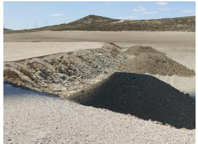
Izda., plataforma y entorno del ACS 03, ya restaurado a falta de remates. Dcha., terraplén de la plataforma, afectado por la tormenta, y tierra vegetal acopiada para su restauración.
