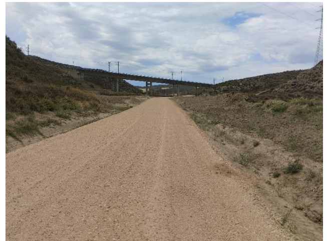
Camino 4, de acceso al ACS 05: sector intermedio. En la fotografía de la izquierda se destaca el terraplén excesivamente pedregoso en el que hay que añadir más tierra vegetal
