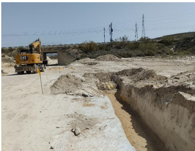
Trabajos de reparación de cable en el tramo de zanja de acceso a la SET.
