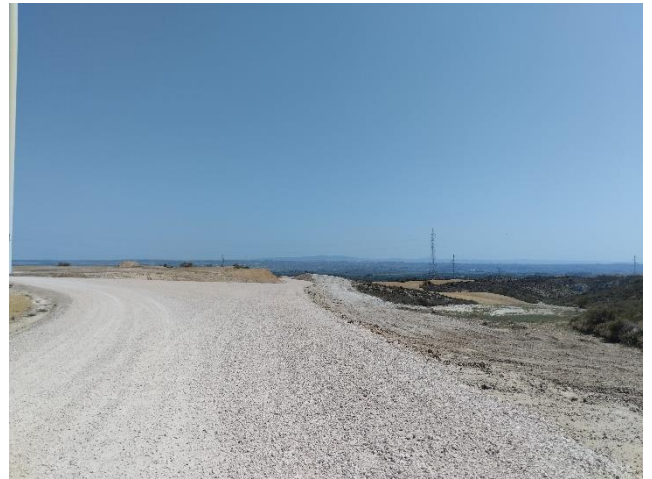
Vial de acceso a los aerogeneradores ACS 01 y ACS 02: zanja y terraplenes ya restaurados.
