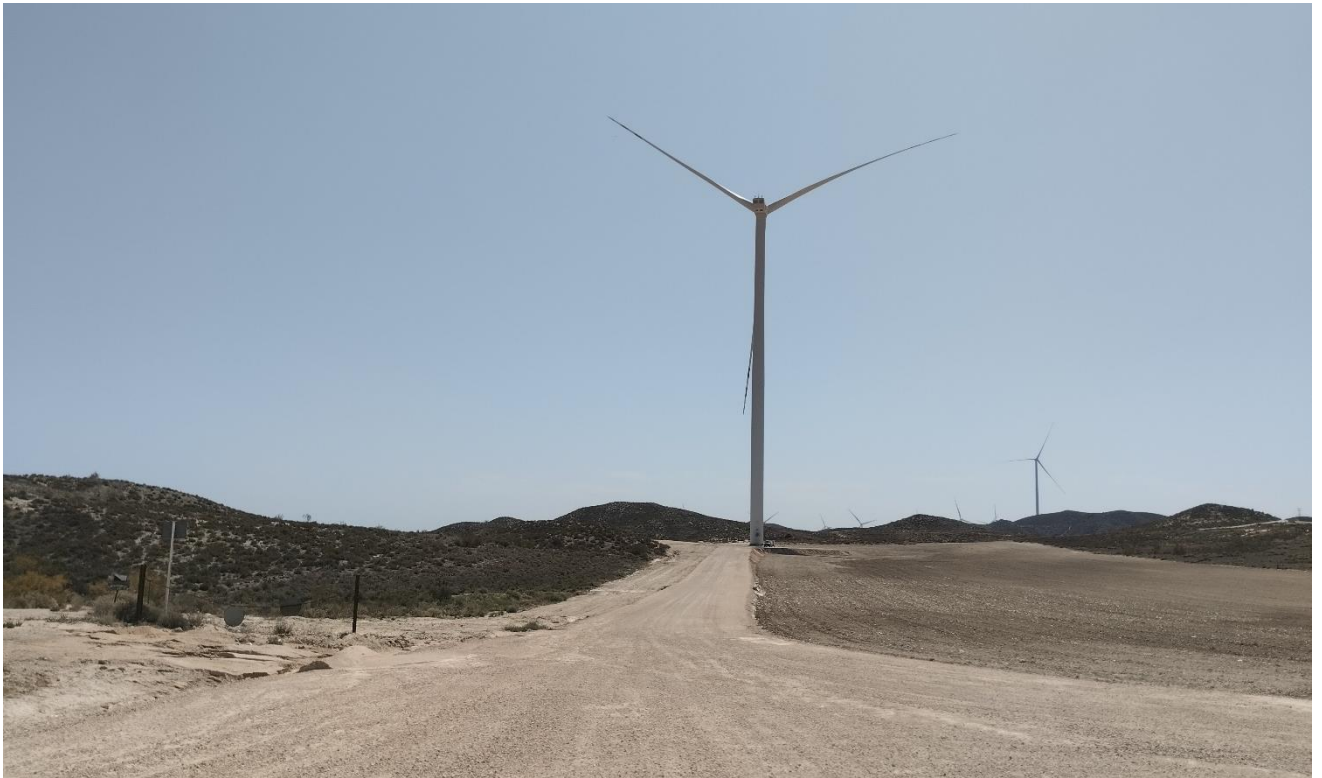
Plataforma y entorno del ACS 03, ya restaurado (a falta de remates), vista desde el oeste.
