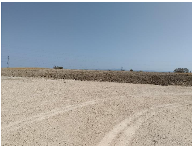
Plataforma del ACS 02, casi completamente restaurada: aquí se acopian aún tierras que serán empleadas en el relleno de la zona de giro adyacente al ACS 01, así como una reserva de tierra vegetal, para extender donde se necesite.
