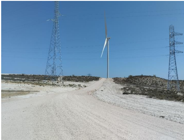
Vial de acceso a los aerogeneradores ACS 01 y ACS 02: zanja y terraplenes ya restaurados.
