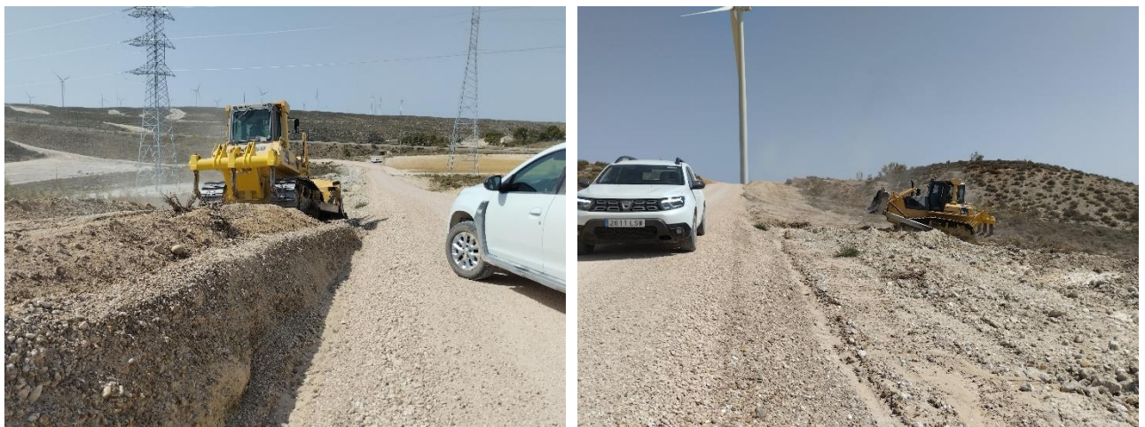
Trabajos de restauración de zanja junto al tramo de vial de acceso al ACS 02
