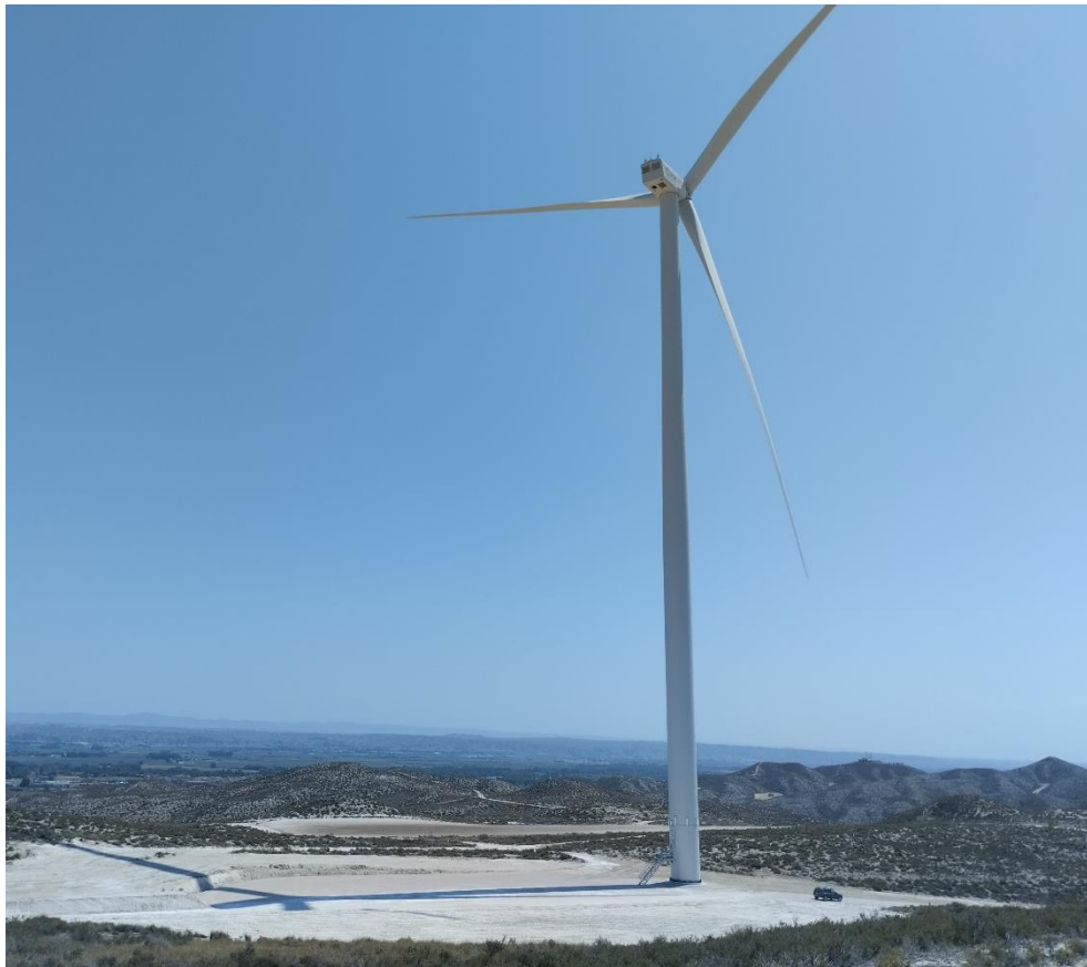
Plataforma y entorno del ACS 04, vista desde el sur
