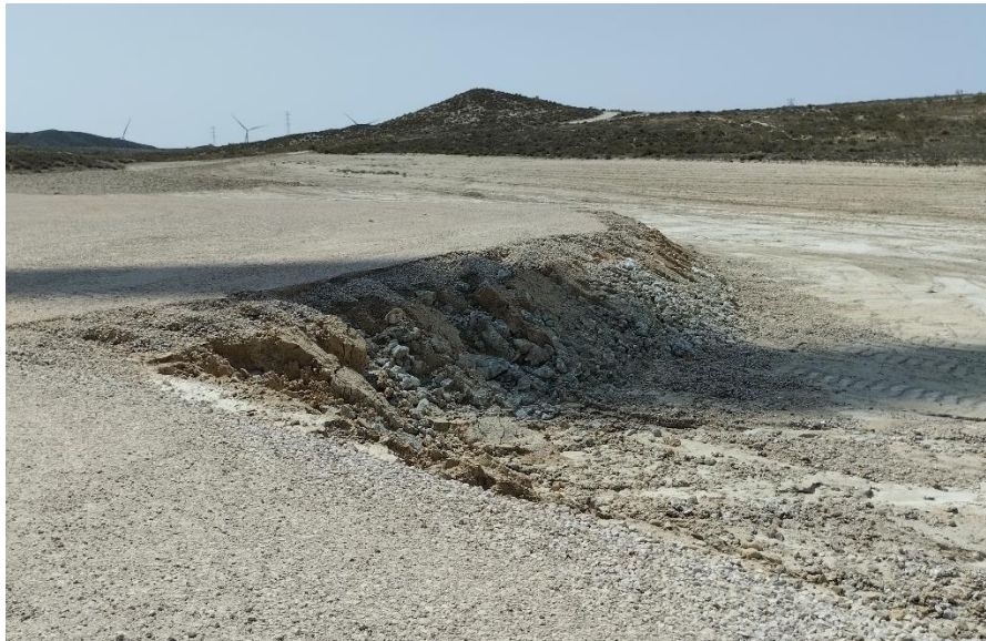
Detalle del terraplén de la plataforma ACS 03: se reconstruirá añadiendo más tierra vegetal.
