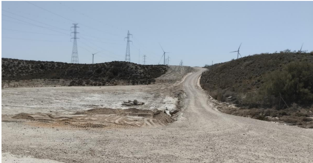
Vial de acceso al sector este del PE, muy afectado por la tormenta, comenzando a repararse.
