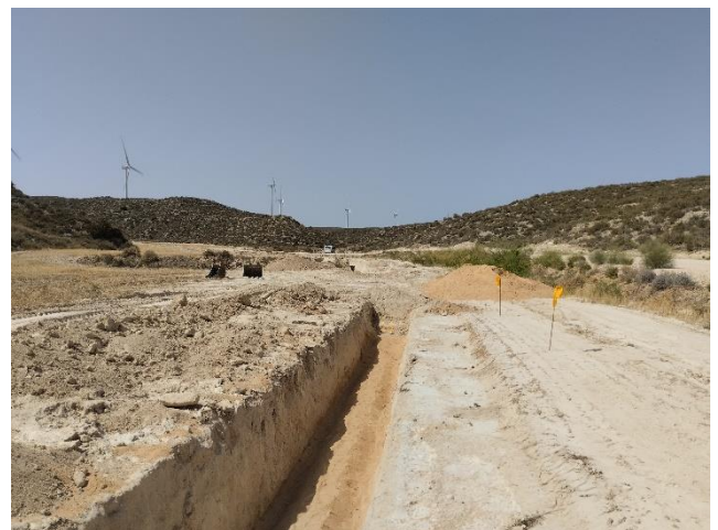
Trabajos de reparación de cable en el tramo de zanja de acceso a la SET.
