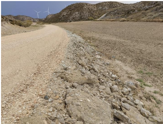
Camino 4, de acceso al ACS 05: sector intermedio. En la fotografía de la izquierda se destaca el terraplén excesivamente pedregoso en el que hay que añadir más tierra vegetal
