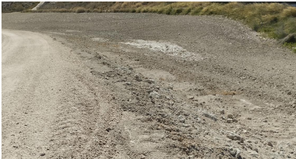
Detalle del terraplén del camino 4 excesivamente pedregosos, ras el añadido de tierra vegetal.
