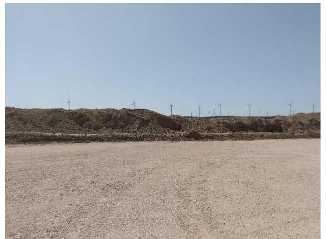
Plataforma del ACS 02, casi completamente restaurada: aquí se acopian aún tierras que serán empleadas en el relleno de la zona de giro adyacente al ACS 01, así como una reserva de tierra vegetal, para extender donde se necesite.
