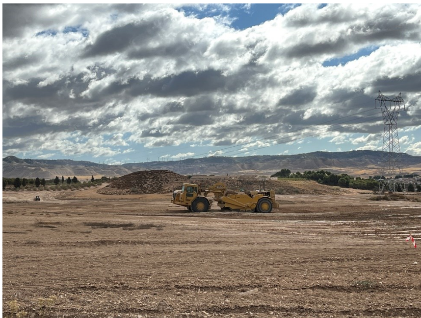
Figura 2 Trabajos de movimientos de tierras
