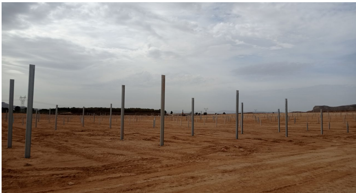
Figura 2b Detalle de los trabajos de hincado
