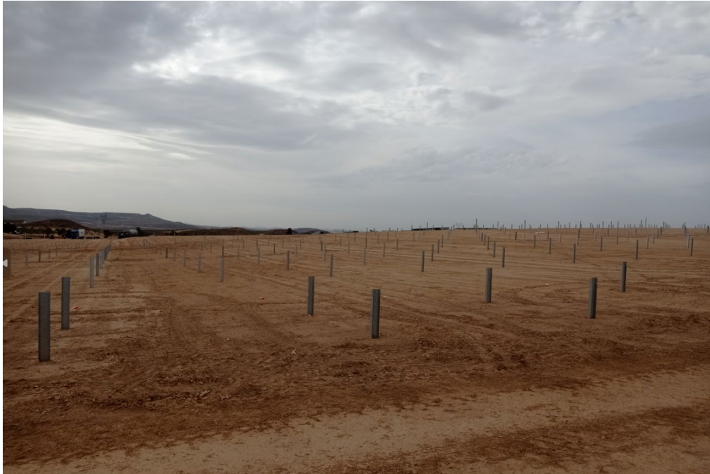
Figura 8 Trabajos de hincado
