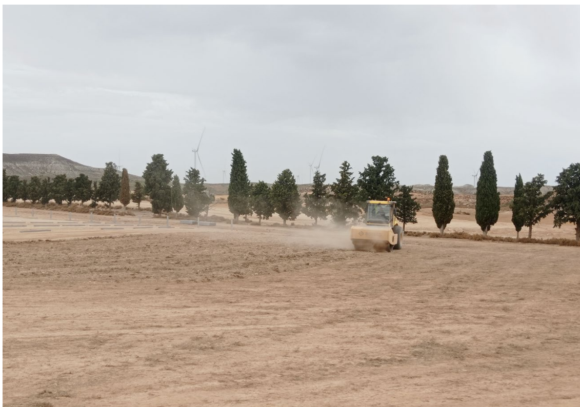
Figura 2 Trabajos de acondicionamiento de superficies
