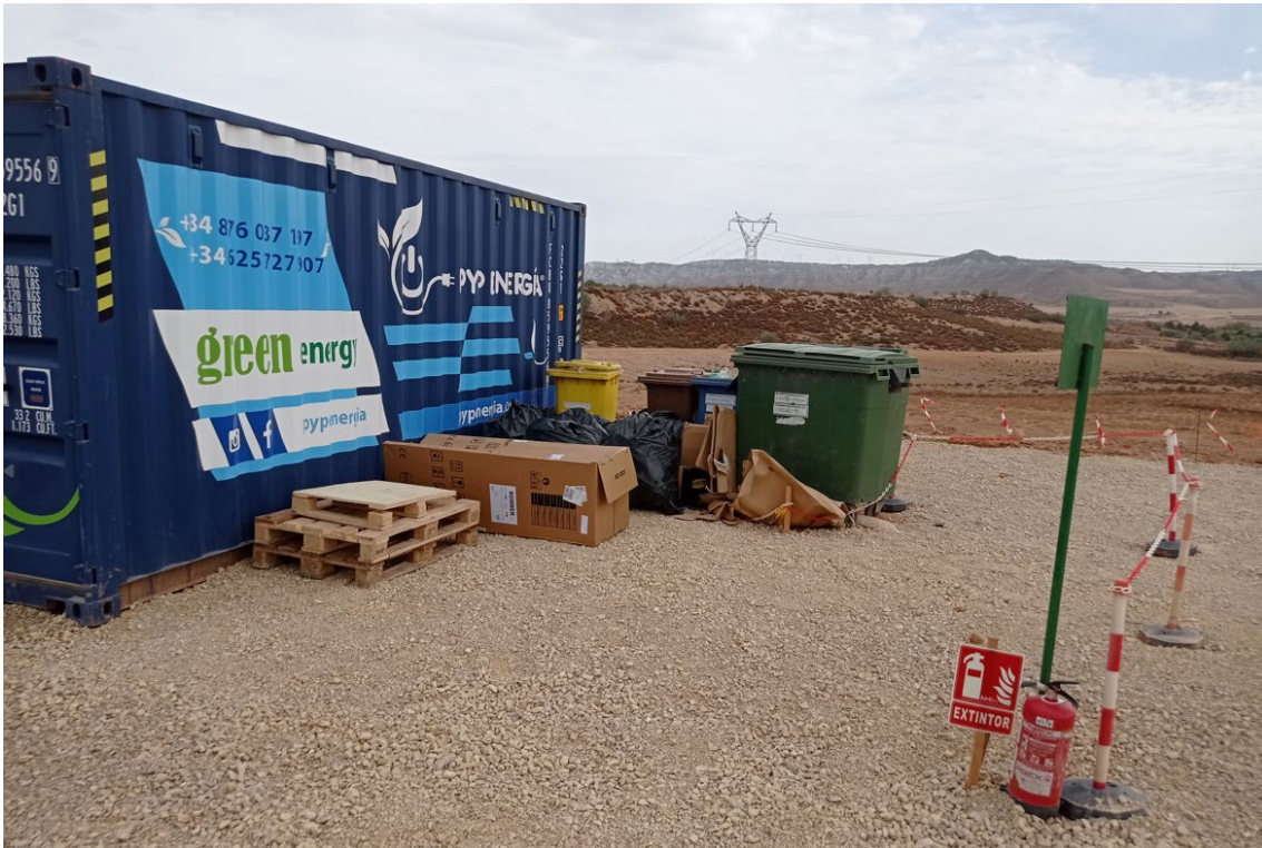
Figura 3 Punto limpio de residuos no peligrosos
