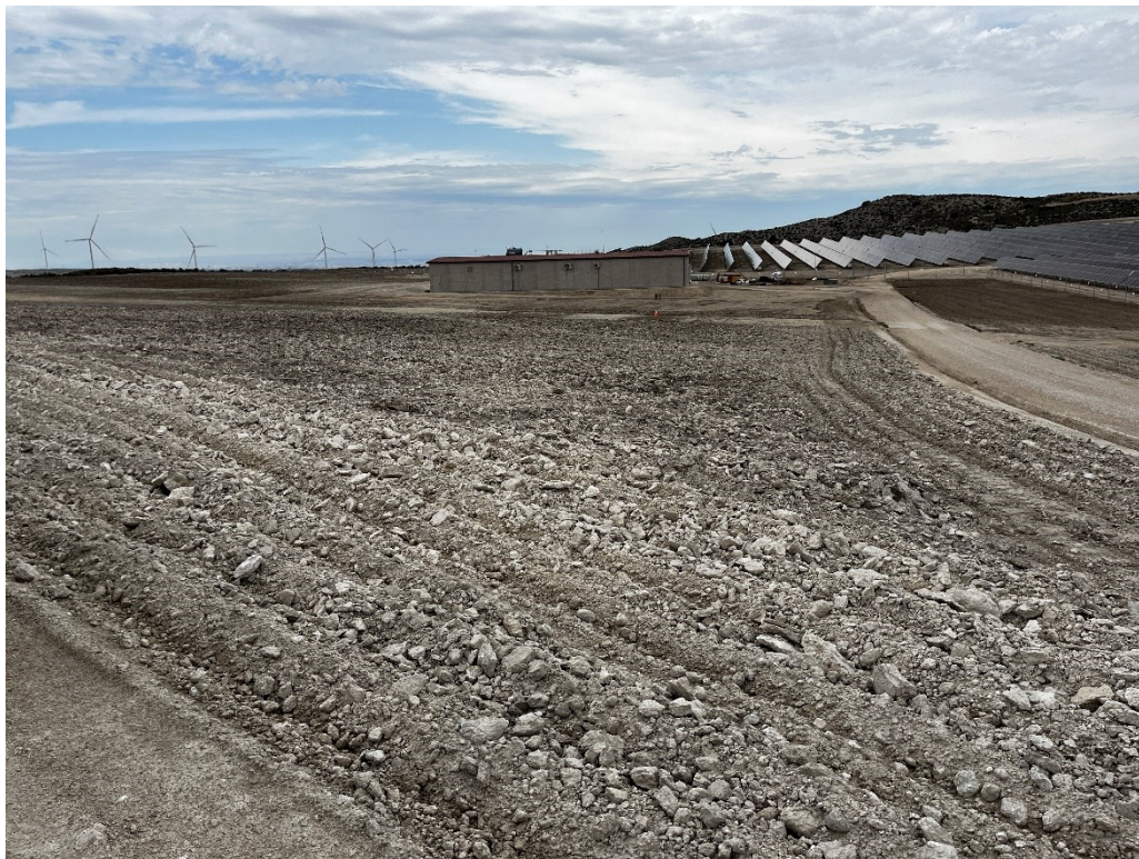
Figura 11 Descompactación de las zonas afectadas por el trascurso de la obra
