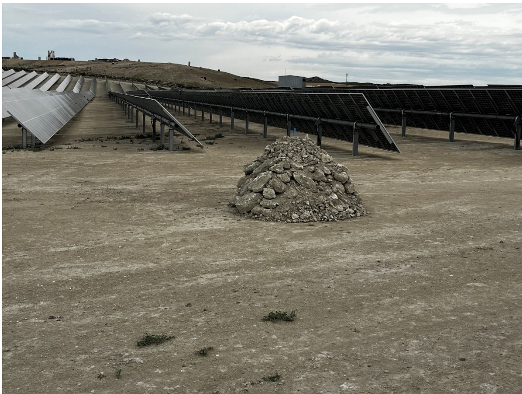
Figura 10 Construcción de los majanos
