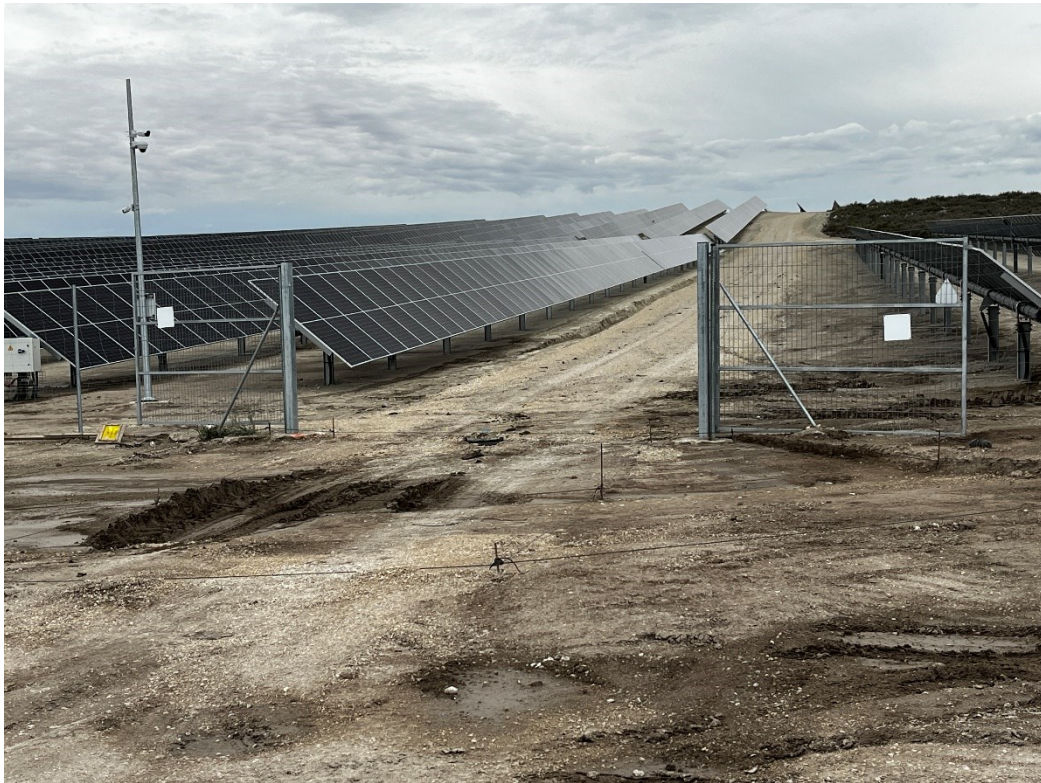
Figura 9 Cimentación del vial
