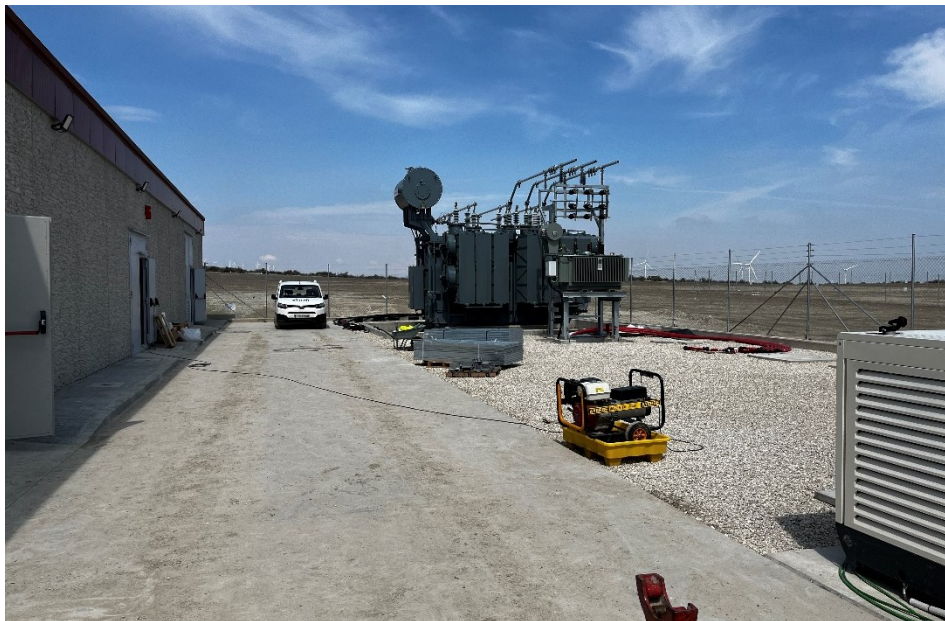
Figura 7 Trabajos de la SET
