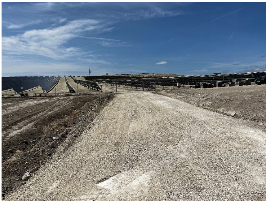
Figura 2 Restauración de los viales
