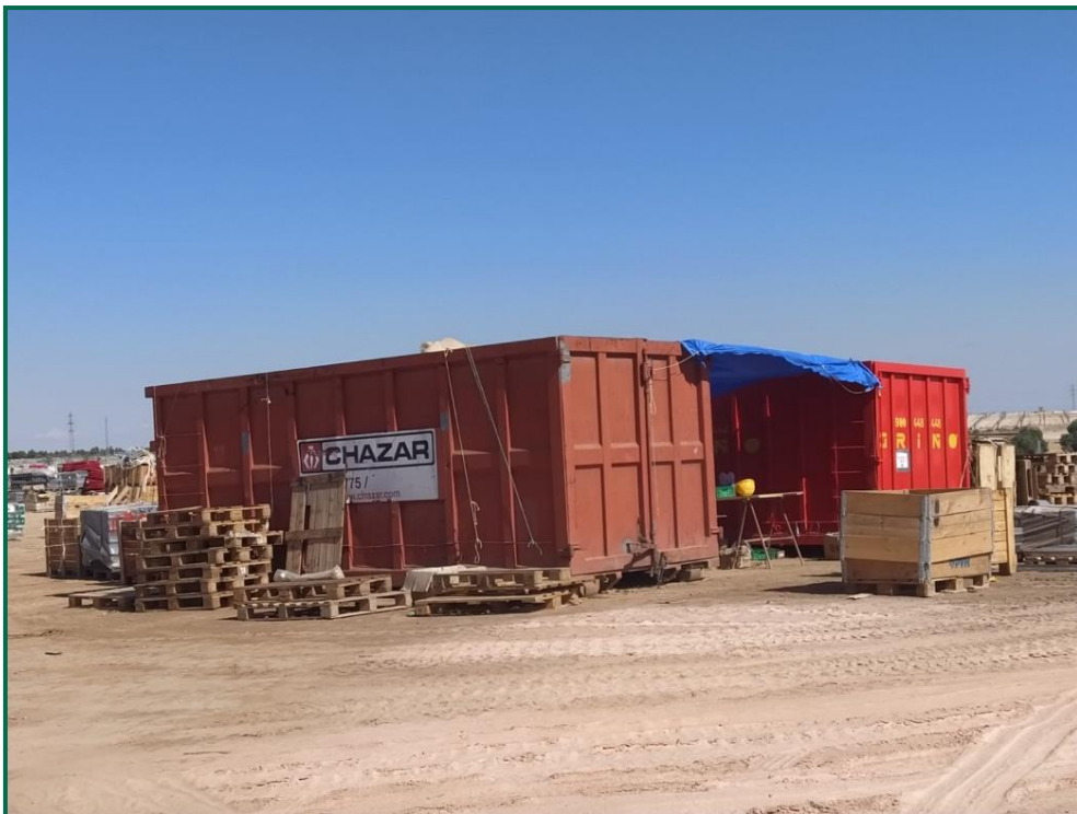
Fotografía 10. Contenedores residuos inertes
