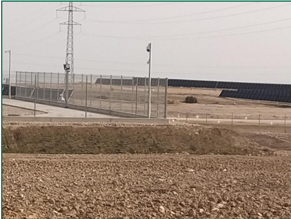
Fotografía 7. Tierra vegetal extendida en el talud de SET Los Arcos.
