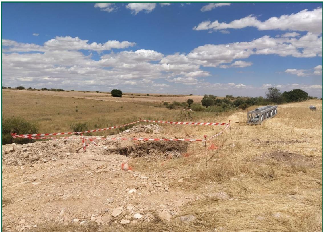
Fotografía 1. Balizado de apoyo excavado.
