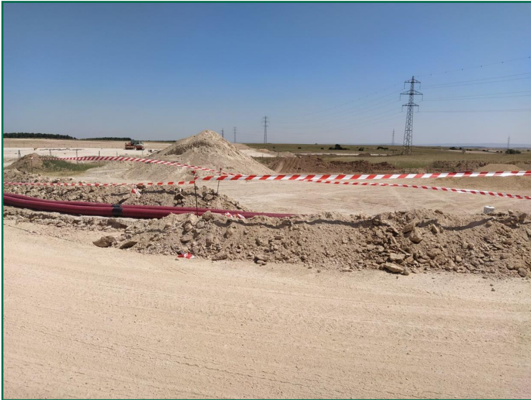
Fotografía 2. Balizado de línea soterrada.
