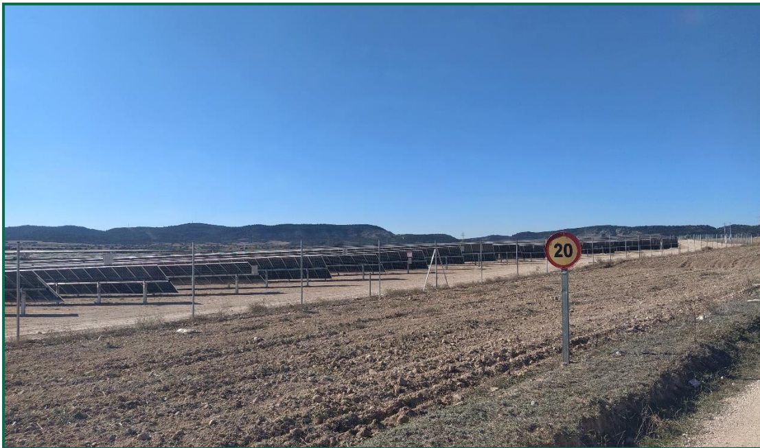
Fotografía 6. Señal de limitación de velocidad.
