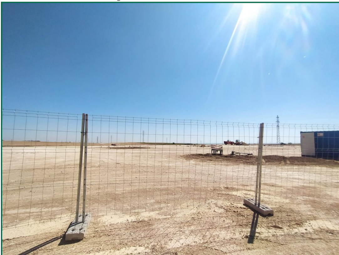
Fotografía 3. Vallado provisional en zona subestación (centro de transformación).
