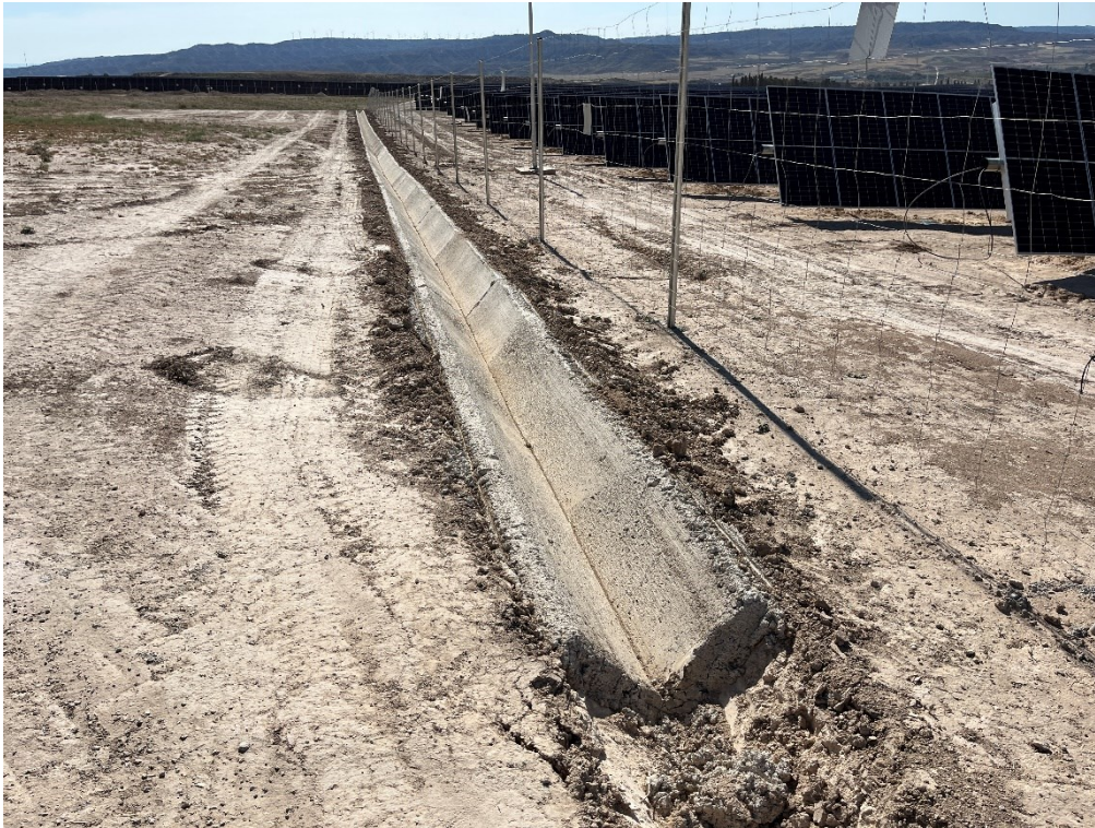
Figura 2 Apertura y cimentación de las cunetas
