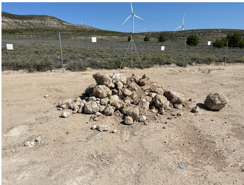
Figura 7 Material para la construcción de los majanos
