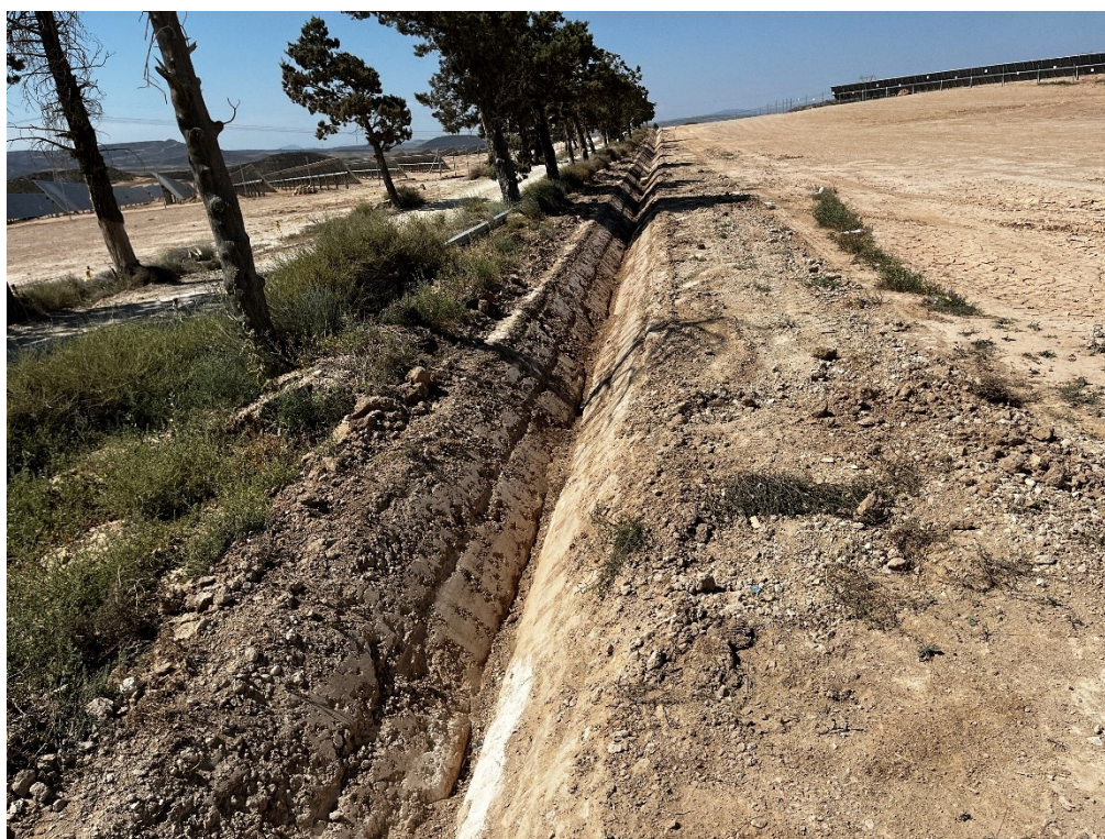
Figura 5 Apertura de las cunetas
