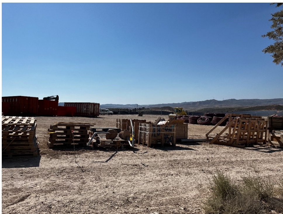
Figura 3 Punto limpio de residuos no peligrosos y acopio temporal de residuos
