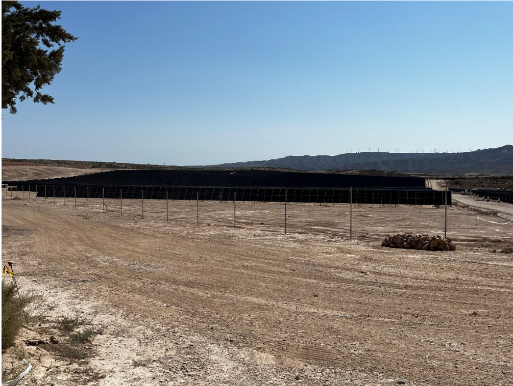
Figura 4 Vallado perimetral sin placas esteparias
