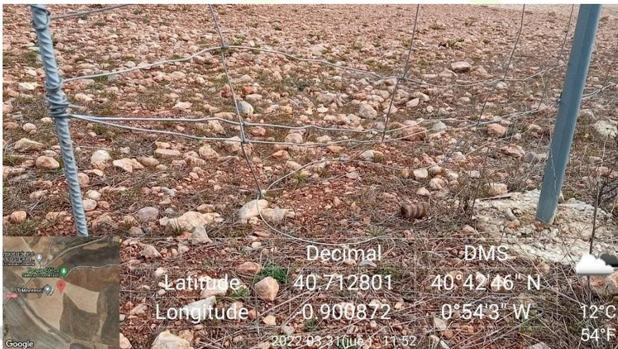
*Ilustración 2. Rotura del vallado en su parte inferior por paso de fauna.*
