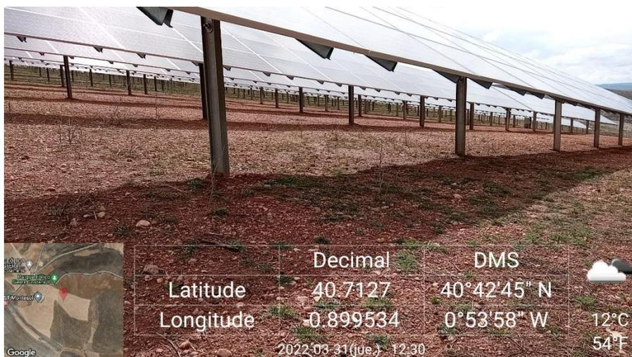
Ilustración 3. Bajo porcentaje de crecimiento de vegetal bajo los paneles en algunos tramos de los campos
