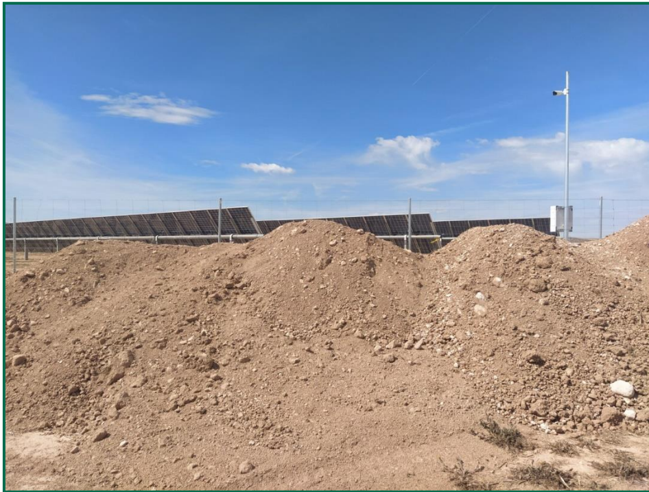
Fotografía 4. Acopio de tierra.
