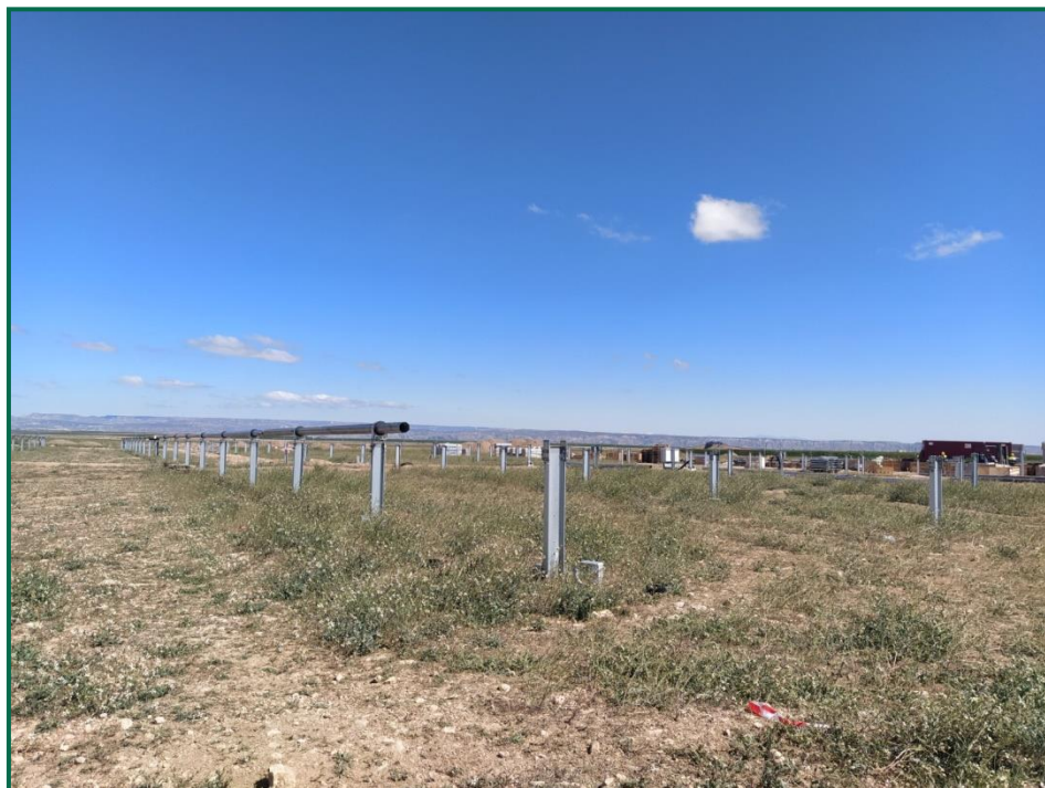
Fotografía 5. Hincas sobre el terreno.
