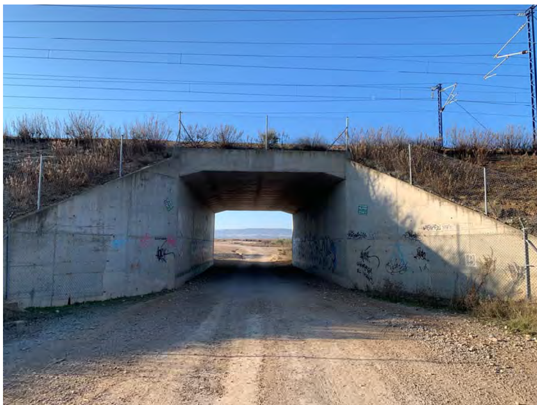
Cruzamiento LAV “Madrid-Zaragoza-Barcelona” por paso existente
