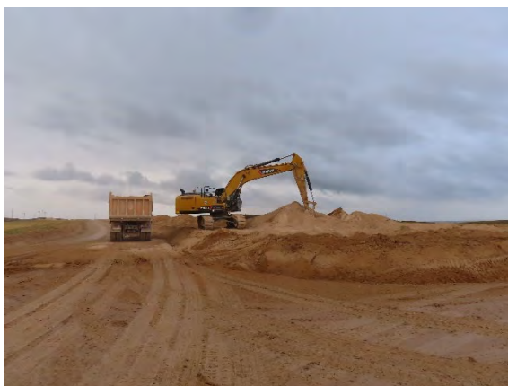
Tierras sobrantes de la excavación del acceso al aerogenerador REIIA-01.
