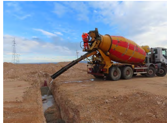
Lavado de hormigonera en zanja recientemente hormigonada.
