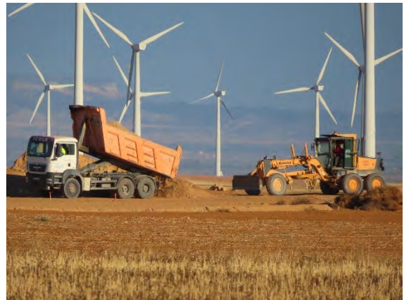
Aporte y extendido de tierras en uno de los viales.
