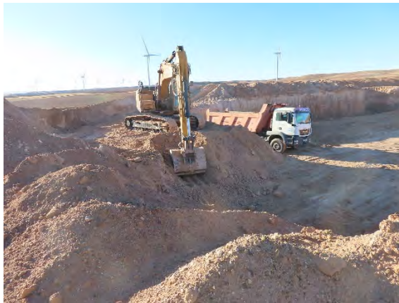
Extracción de tierras en área de préstamo.
