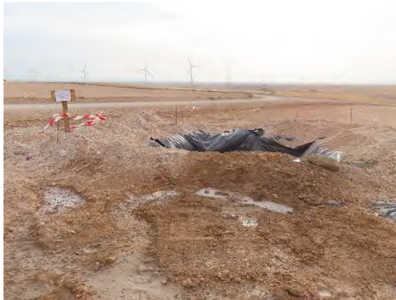
Pozo de lavado junto a la obra de la SET.
