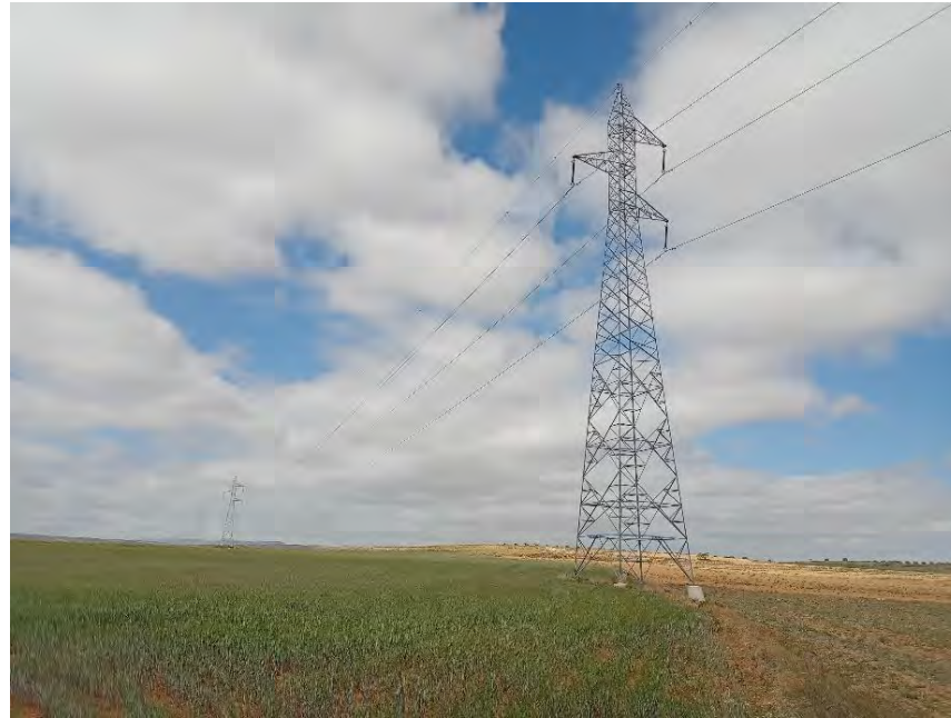
Fotografía 1: Visibilidad línea de tensión
