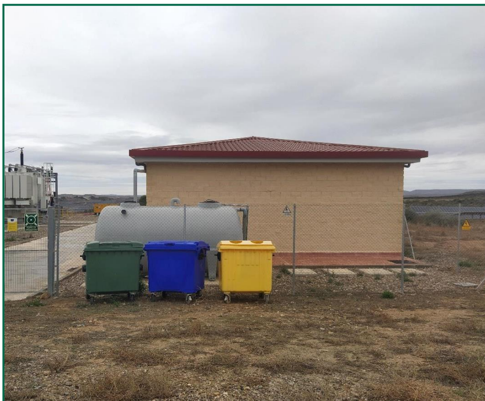
Fotografía 9. Contenedores de residuos no peligrosos en exterior de la subestación.
