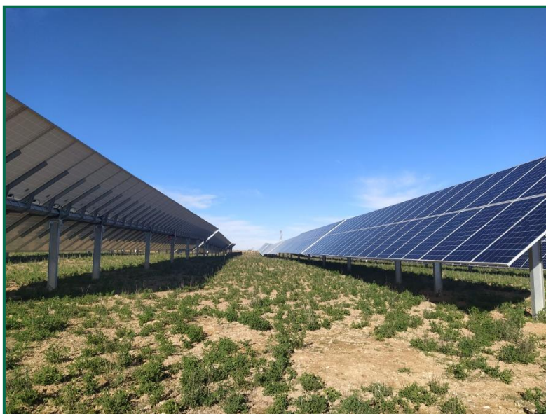
Fotografía 1. Vegetación entre placas actualmente.
