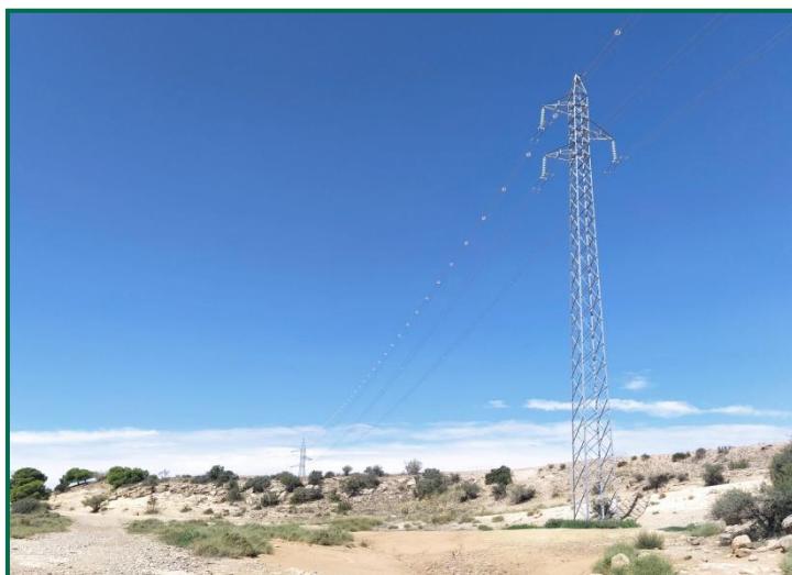
Fotografía 4. Línea eléctrica con balizas salvapájaros
