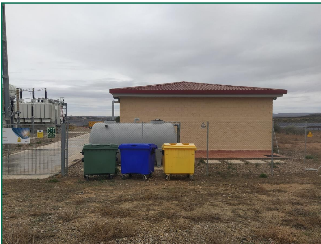
Fotografía 10. Contenedores de residuos no peligrosos en exterior de la subestación.
