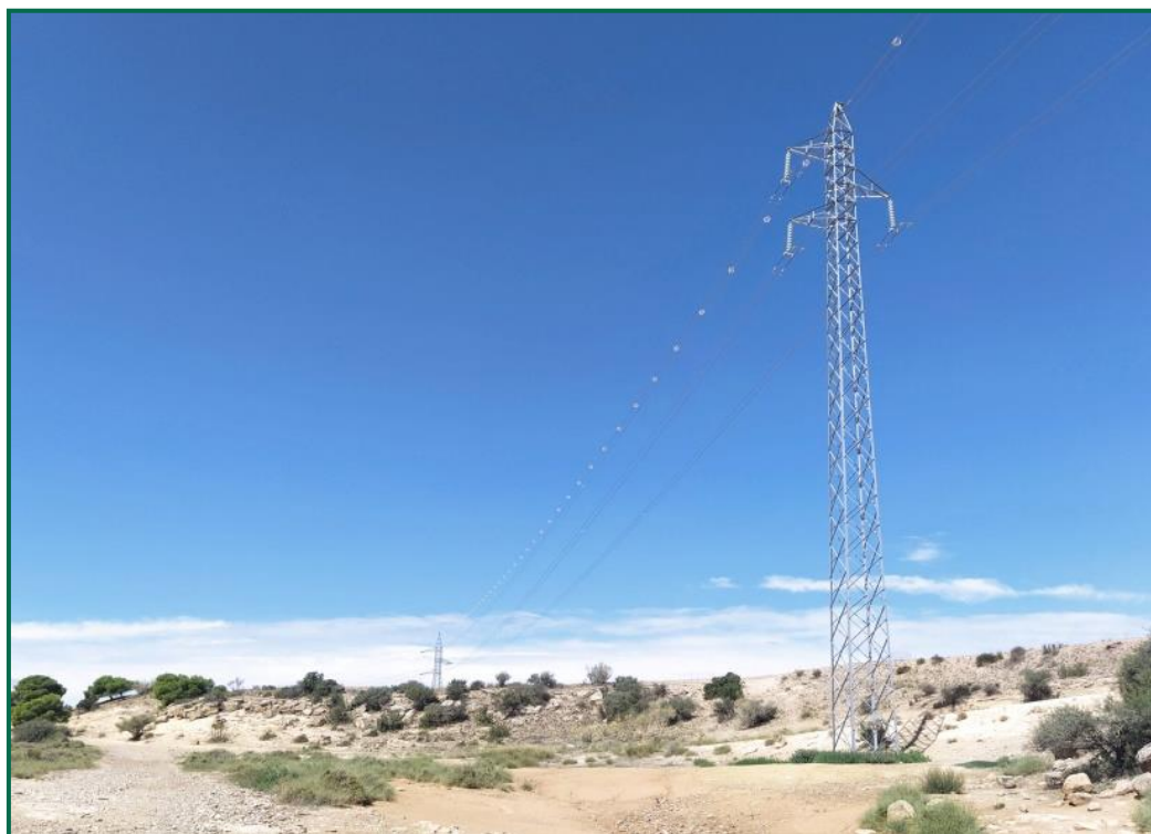
Fotografía 9. Línea eléctrica con balizas salvapájaros
