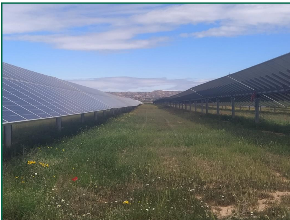
Fotografía 1. Vegetación entre placas actualmente.
