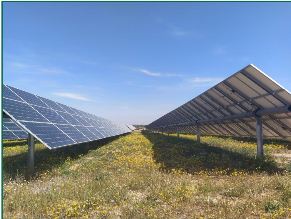
Fotografía 1. Vegetación entre placas actualmente.
