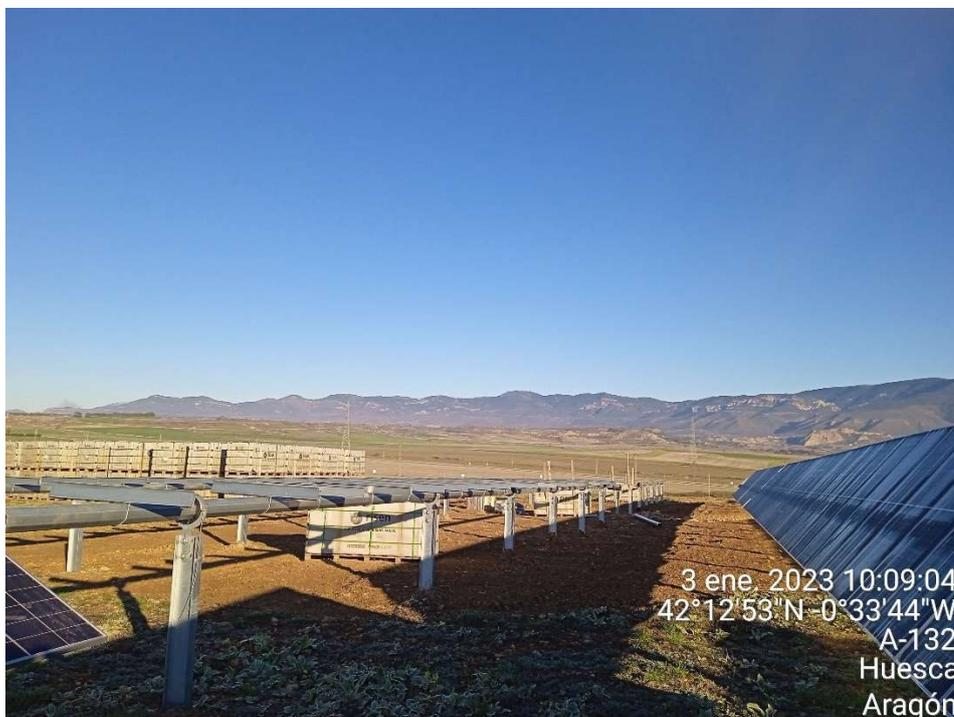
Imagen 8. Módulos fotovoltaicos almacenados. En primer plano los palets de módulos distribuidos para su instalación.
