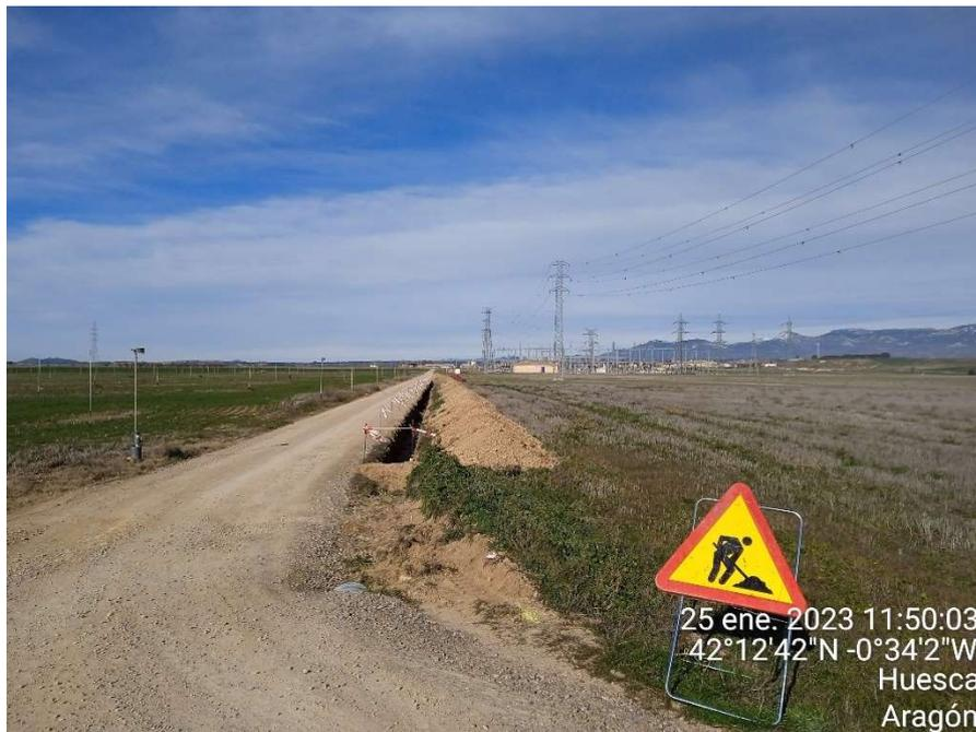
Imagen 2.- Señalización y balizado de las obras de la línea de evacuación.
