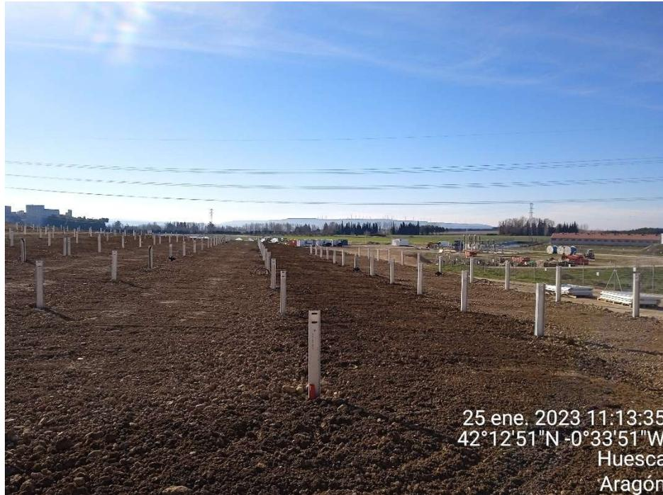
Imagen 5.- Última zona en la que se han colocado los postes de los seguidores y se ha extendido la capa de tierra vegetal.
