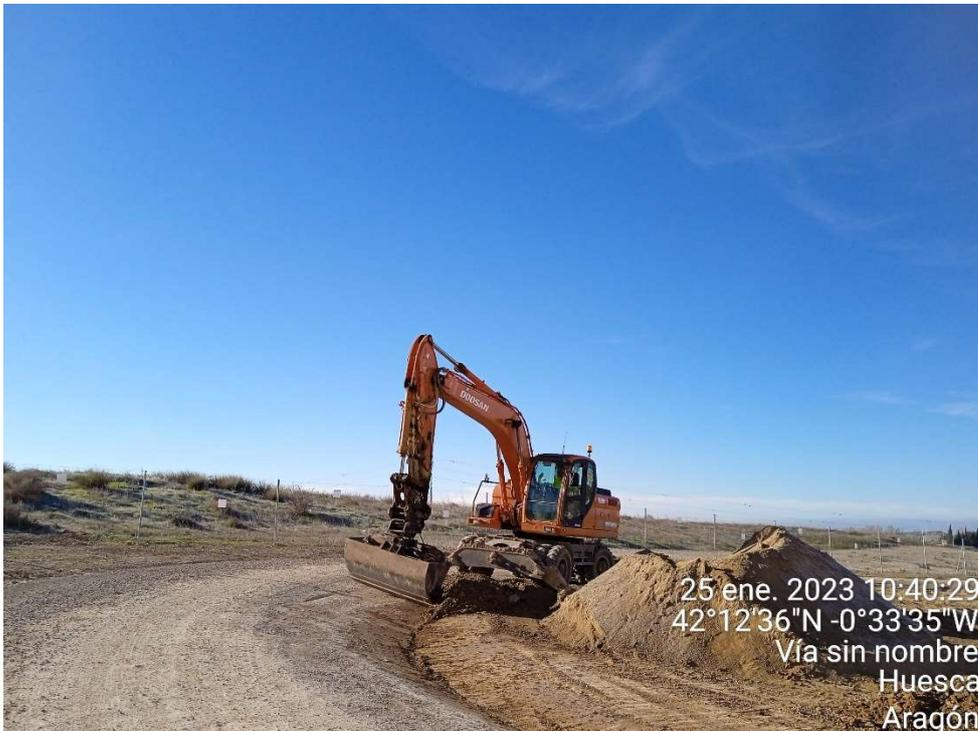
Imagen 19.- Máquina trabajando en el reperfilado del camino perimetral.
