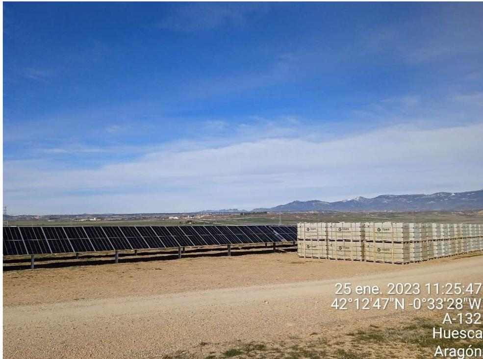
Imagen 9. Módulos fotovoltaicos almacenados.
