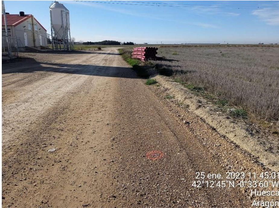
Imagen 1.- Replanteo de la zanja de la línea de evacuación de la planta fotovoltaica, por el lateral del camino de acceso.
