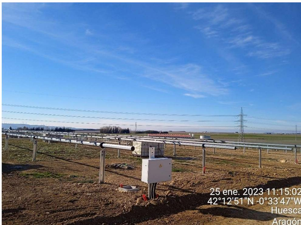
Imagen 6. Seguidores de los módulos fotovoltaicos, conexión con las conducciones de baja tensión y módulos preparados para su instalación.
