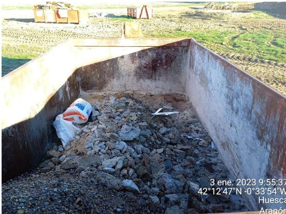
Imagen 16.- Contenedor para residuos de hormigón del Punto limpio de Residuos no peligrosos.
