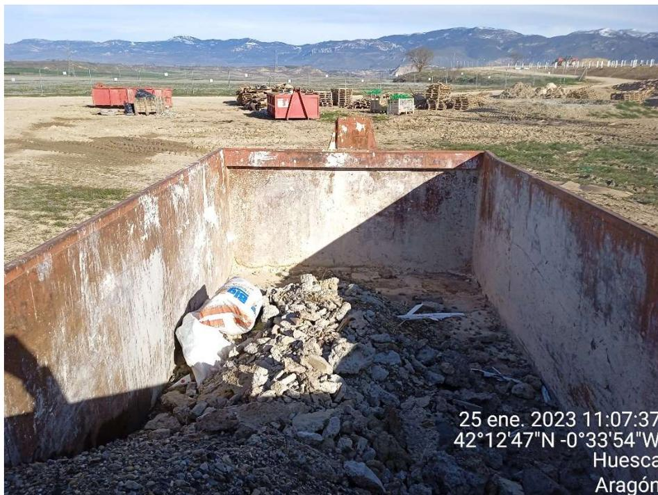
Imagen 18.- Contenedor para residuos de hormigón del Punto limpio de Residuos no peligrosos.
