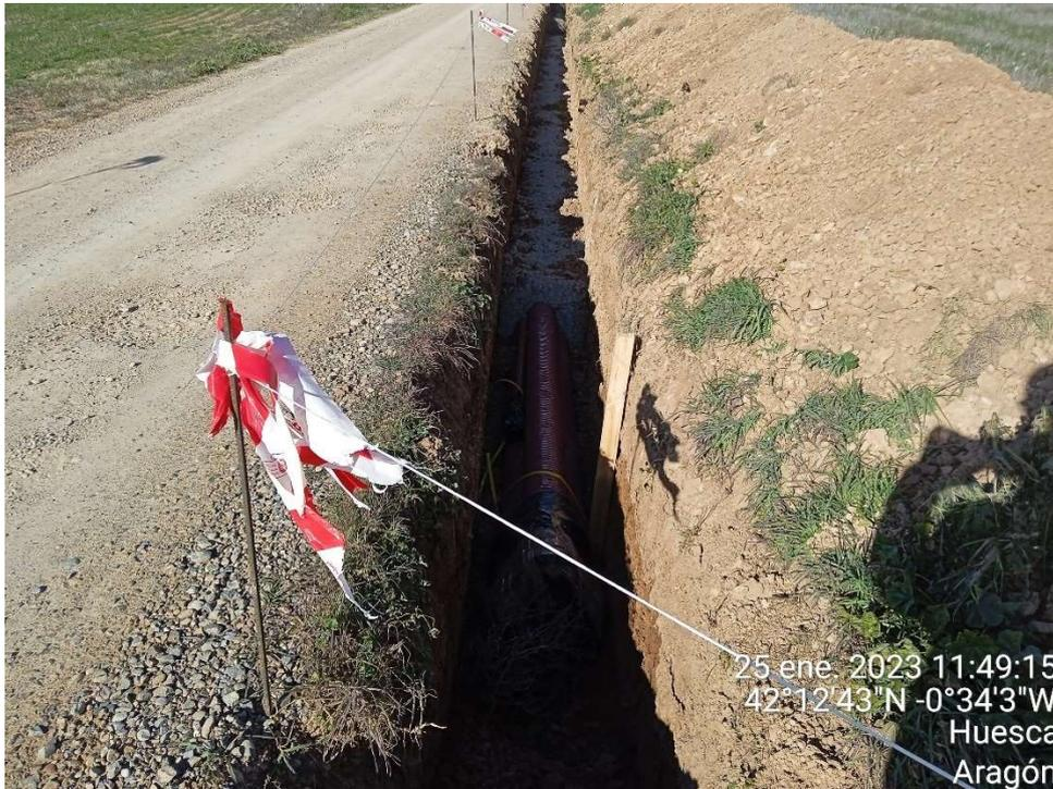
Imagen 3.- Detalle de la zanja y tubos de la línea de evacuación
