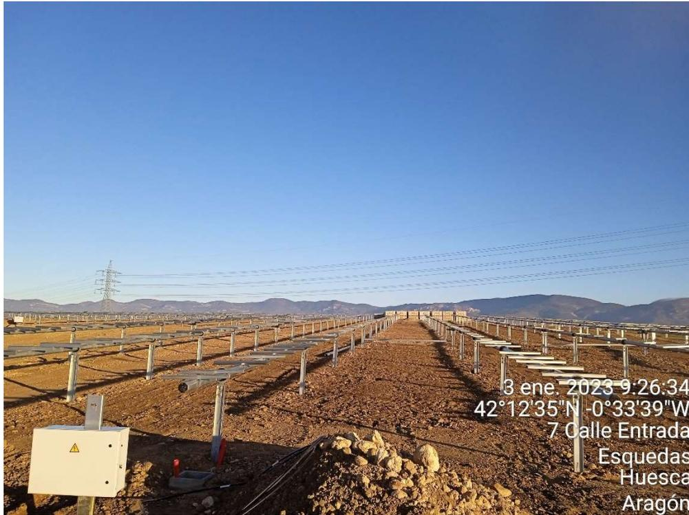
Imagen 3. Montaje de los seguidores de los módulos fotovoltaicos.
