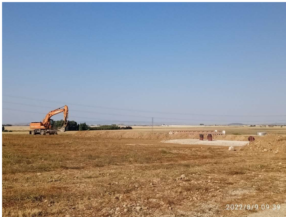
Imagen 7. Trabajos en la base de uno de los tres C.T.s y en la zanja para conducciones de media tensión.
