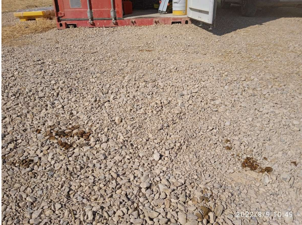
Imagen 13.- Derrames en la entrada del contenedor que funciona como Punto limpio de Residuos peligrosos.
