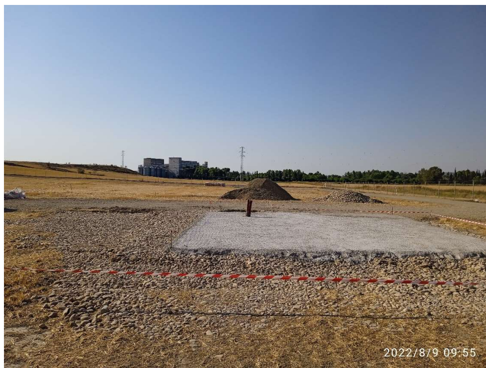
Imagen 8. Base de uno de los CTs hormigonada.
