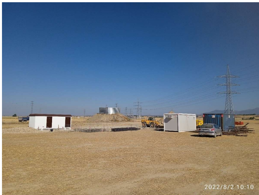
Imagen 6.- Zona de trabajo en la Subestación de transformación.
