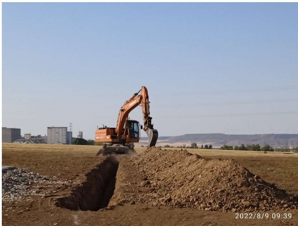
Imagen 9.- Máquina trabajando en la zanja para conducción de media tensión.
