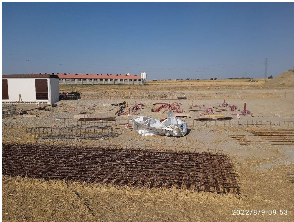
Imagen 11.- Trabajos en los cimientos de la futura Subestación de la PSFV.
