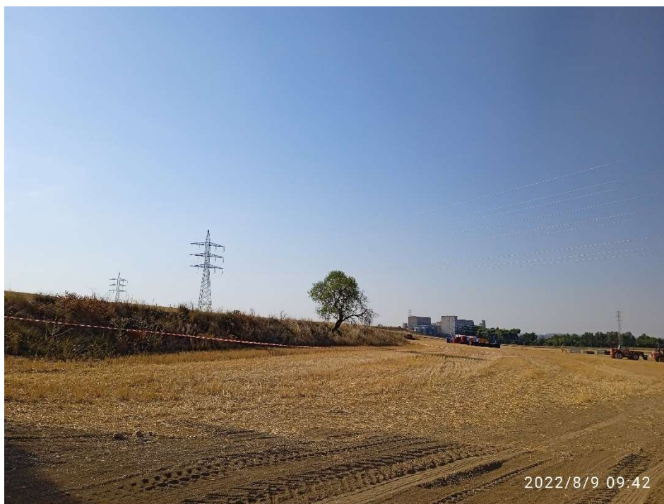
Imagen 1. Talud a suavizar, cercano a zona de instalaciones auxiliares.
