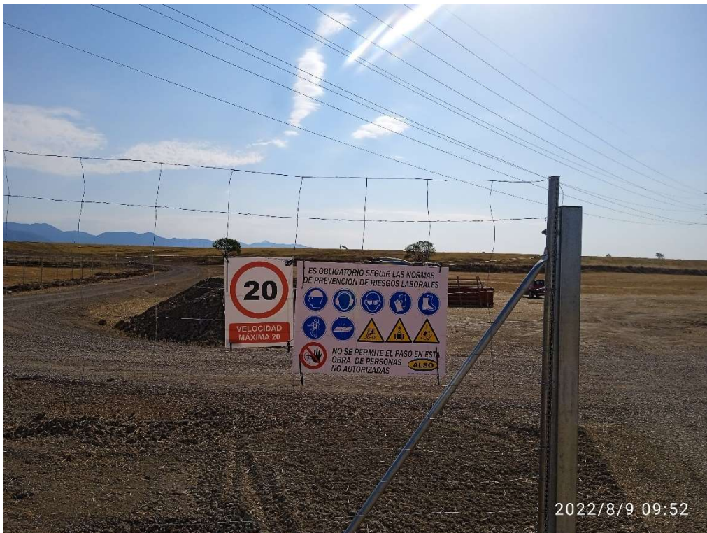
Imagen 4.- Señalización en las entradas a la obra.
