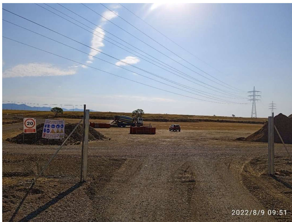
Imagen 2. Acceso principal señalizado.
