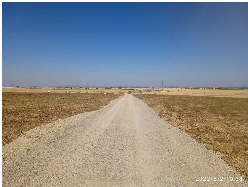
Imagen 3. Vial interior terminado
