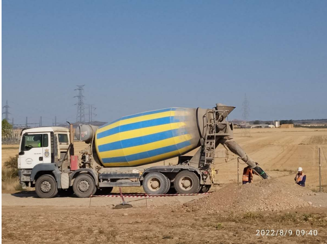
Imagen 5.- Hormigonado de zapata para los postes de las instalaciones de seguridad.
