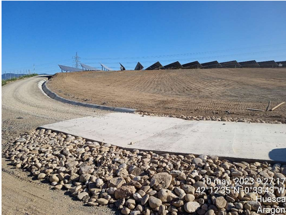
Imagen 13.- Vista de un vado ya terminado.
