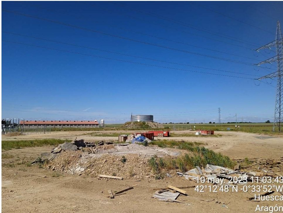
Imagen 7.- Punto limpio de Residuos no peligrosos, con la zona de limpieza de hormigoneras en primer plano.
