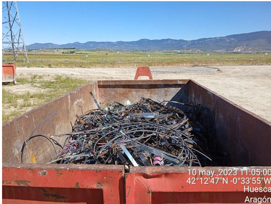
Imagen 9. Contenedor para metal del Punto limpio de Residuos no peligrosos.
