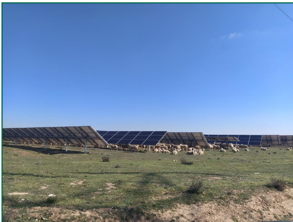
Fotografía 1. Vegetación entre placas actualmente.
