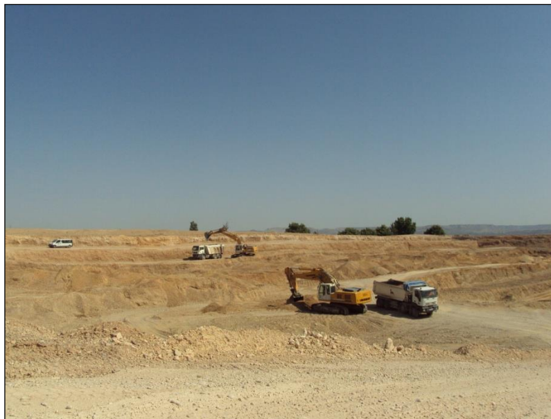
Fotografía.- Vista de la operación. Se observa lo indicado en la memoria. Bancos de operación de 3,5 metros para llegar a los bancos finales de 15 metros, con bermas de anchura mínima de 6 metros.
