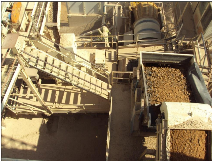
Vista parcial de las instalaciones de tratamiento.
