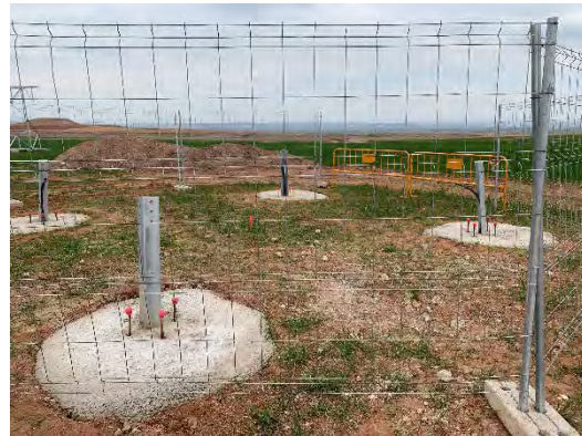
Figura 17 Labores de cimentación
