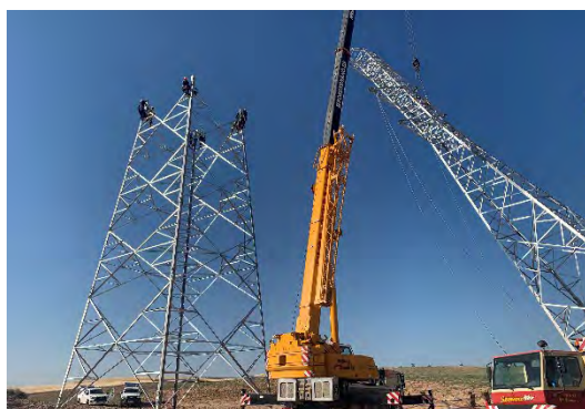
Figura 7 Izado de los apoyos
