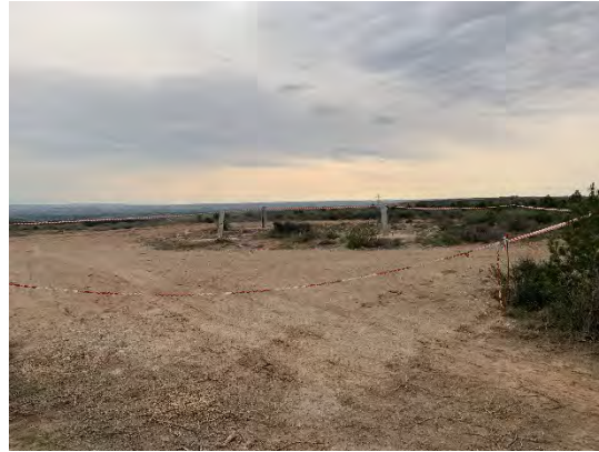
Figura 23 Jalonado de los accesos
