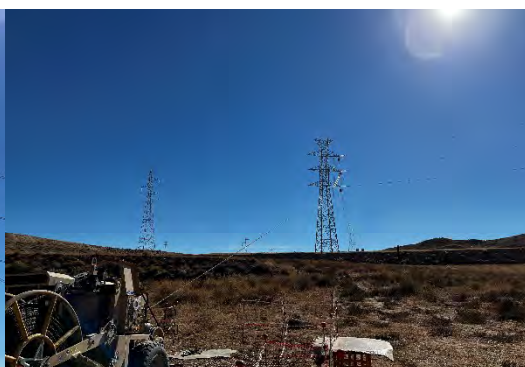
Figura 10 Tendido de cable de alta tensión
