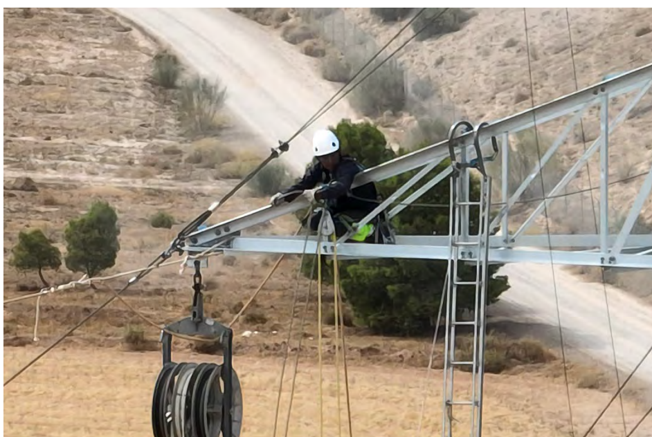
Figura 25 Tirada de cable de alta tensión
