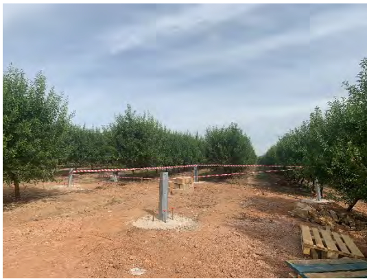
Figura 22 Jalonado de los accesos
