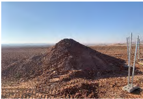
Figura 2 Acopio del material de excavación
