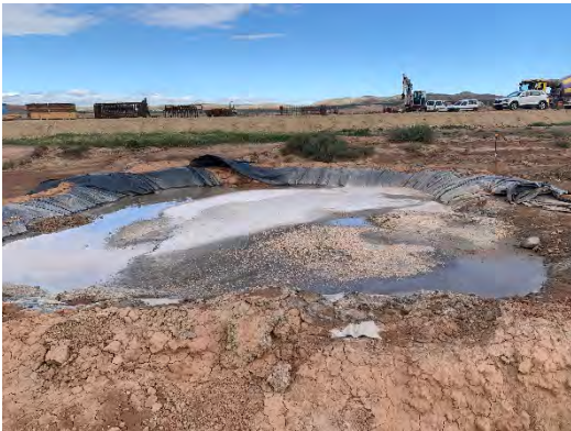
Figura 18 Lavadero de cubas de hormigón
