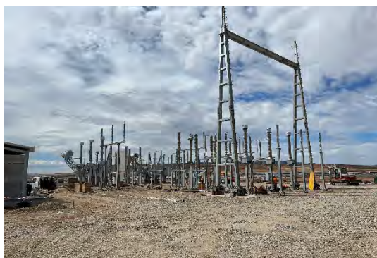
Figura 8 Montaje de la estructura de la SET Valdompere
