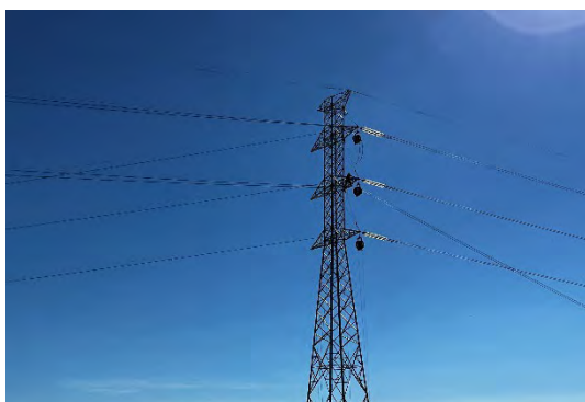
Figura 9 Tendido de cable de alta tensión
