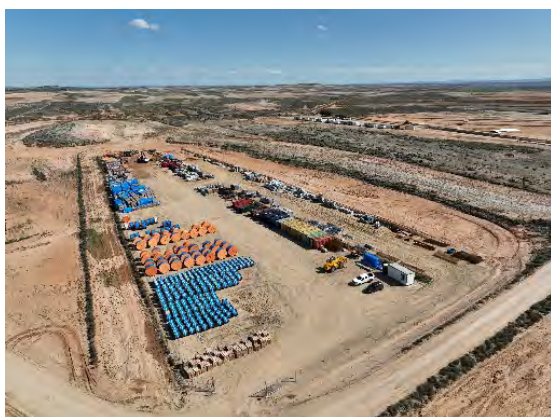
Figura 14 Zona de acopio del material de construcción
