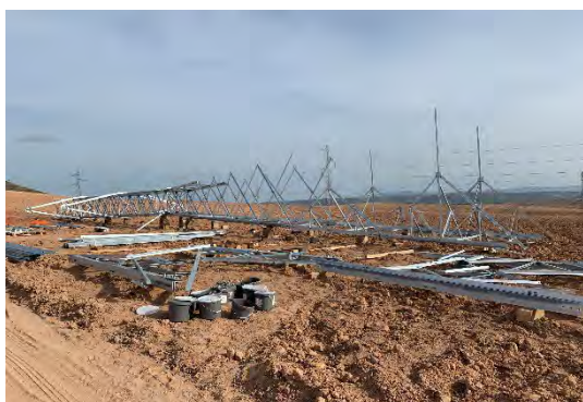
Figura 6 Montaje de los apoyos
