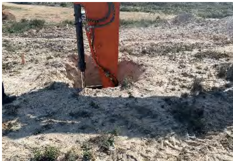
Figura 4 Trabajos de excavación
