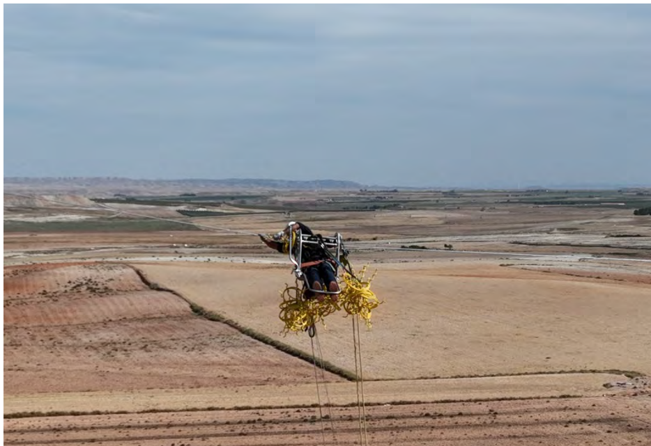
Figura 26 Colocación de las espirales salvapájaros
