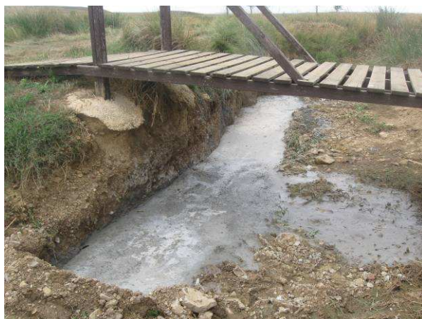
Cimentación de la pasarela Rambla del Royo
