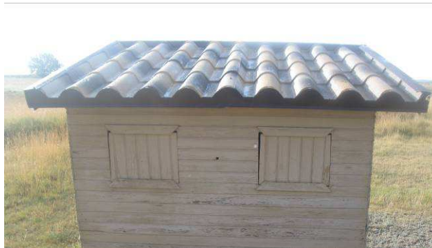
Cubierta de chapa sándwich en hide
