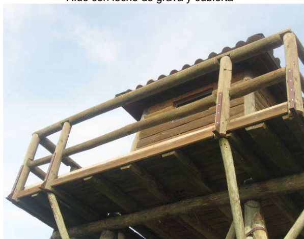
Torre – observatorio del Cañizar con barandilla y cubierta
