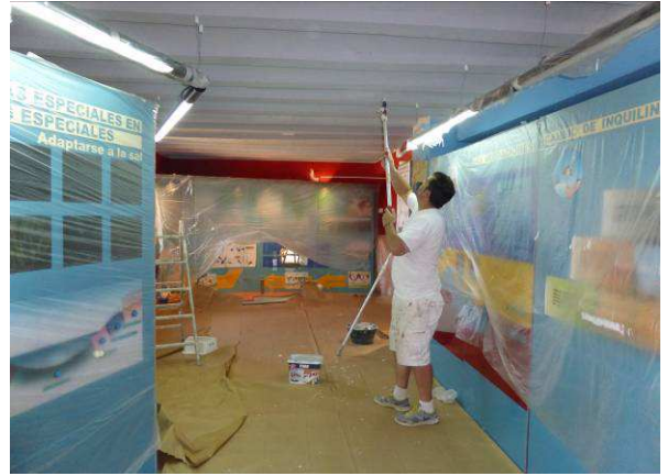
Pintando la planta superior del Centro
