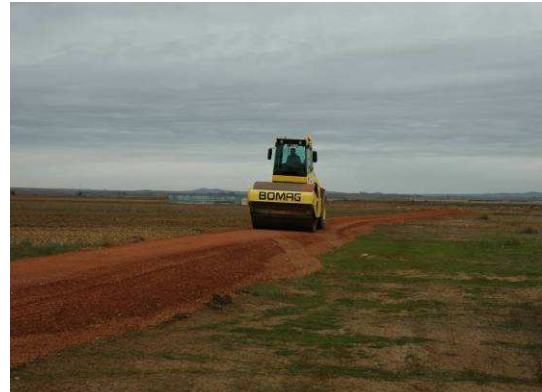
Compactador vibrador compactando el firme
