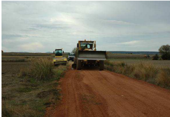
Motoniveladora nivelando el firme
