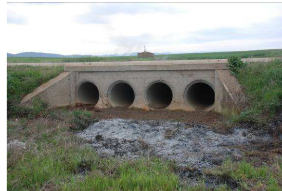
Barranco después de las actuaciones
