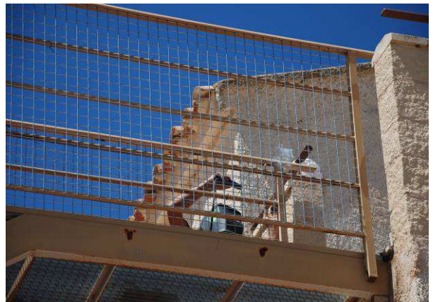
Soldando en la escalera de acceso al observatorio del C.I.
