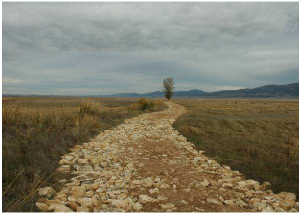
Pedraplén sobre el camino
