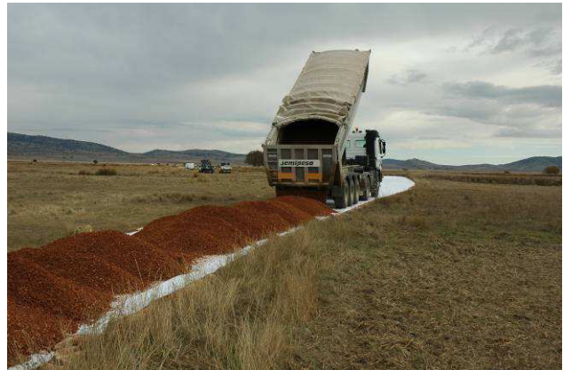
Camión con plataforma depositando zahorra sobre geotextil
