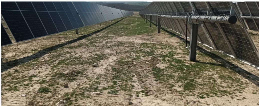
Regeneración de la vegetación en el interior de la planta fotovoltaica
