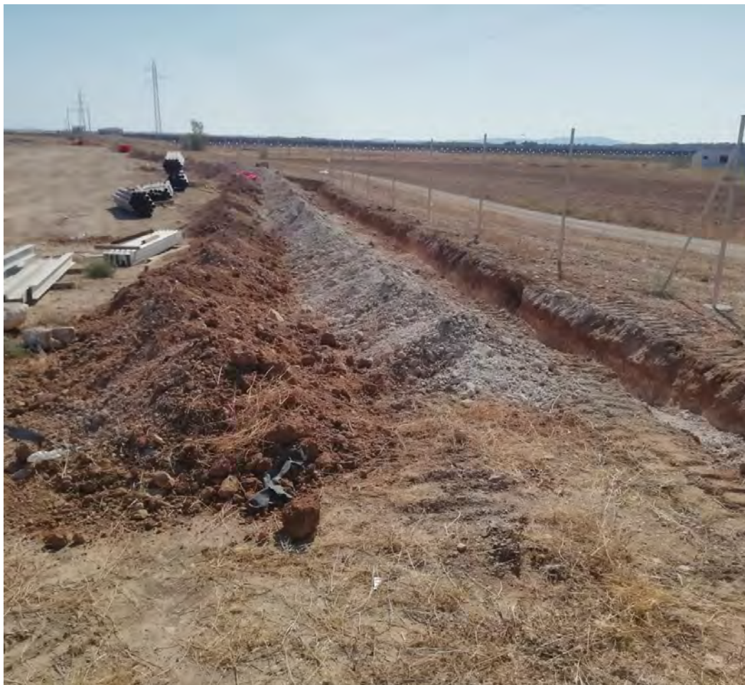
Fig. 1 Separación de tierras en zanja.
