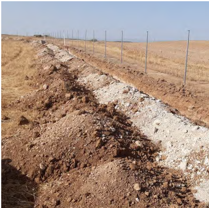
Fig. 1 Cordón de tierra vegetal y cordón de fondo de zanja
