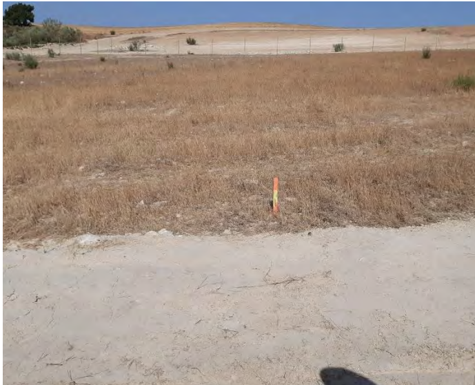
Fig. 1 Estacas marcando límites de movimientos de tierra para evitar afecciones innecesarias.
