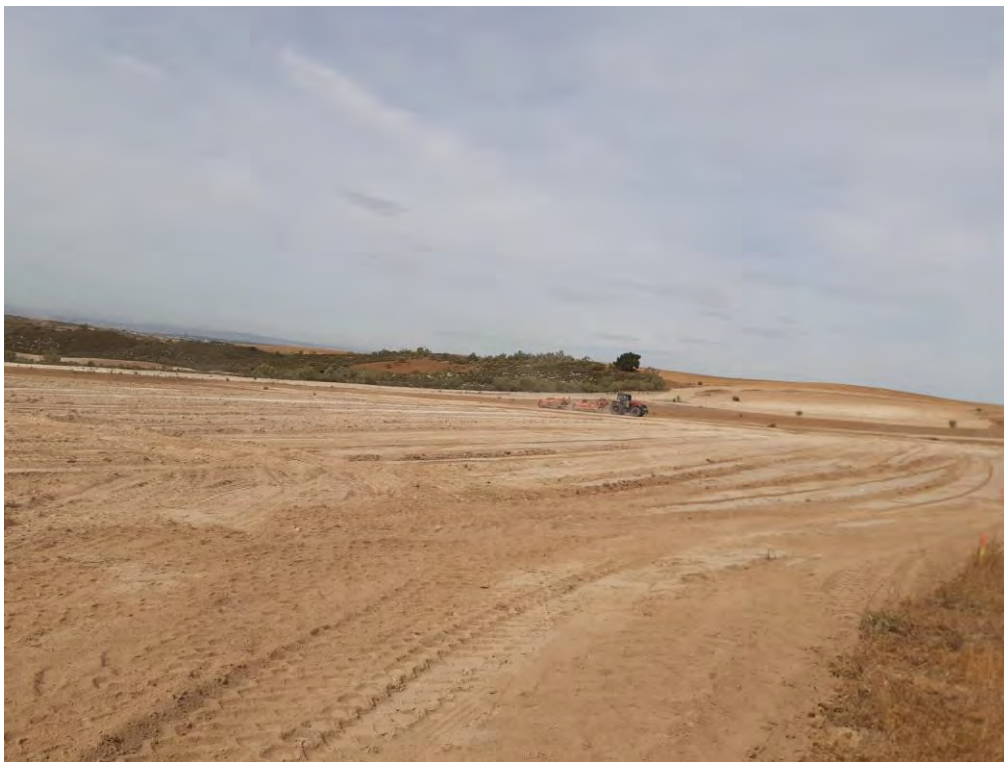
Fig. 1 Trailla repartiendo tierra vegetal
