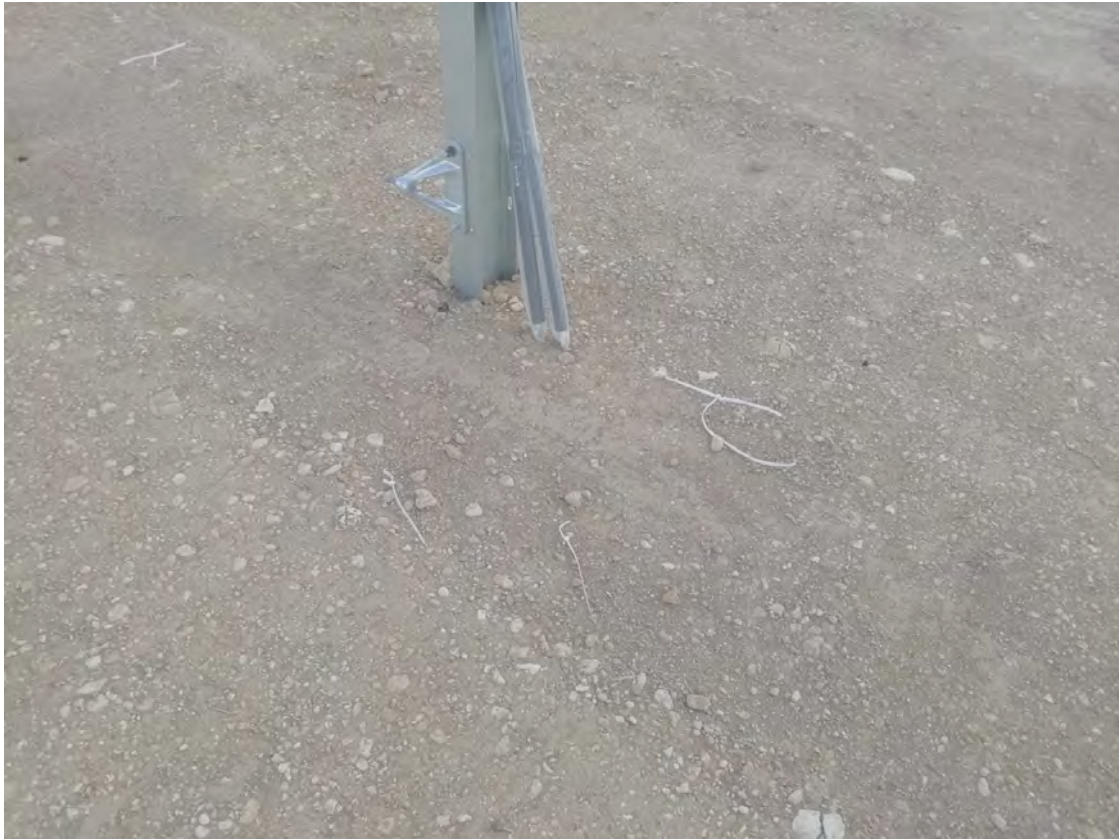
Fig. 1 Restos de plásticos en las zonas de montaje de placas.
