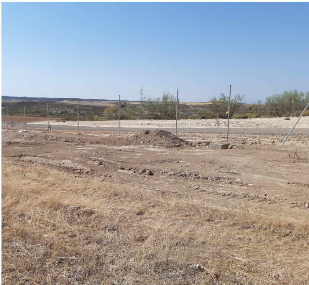
Fig. 1 Zanja cubierta de tierra vegetal una vez cerrada-
