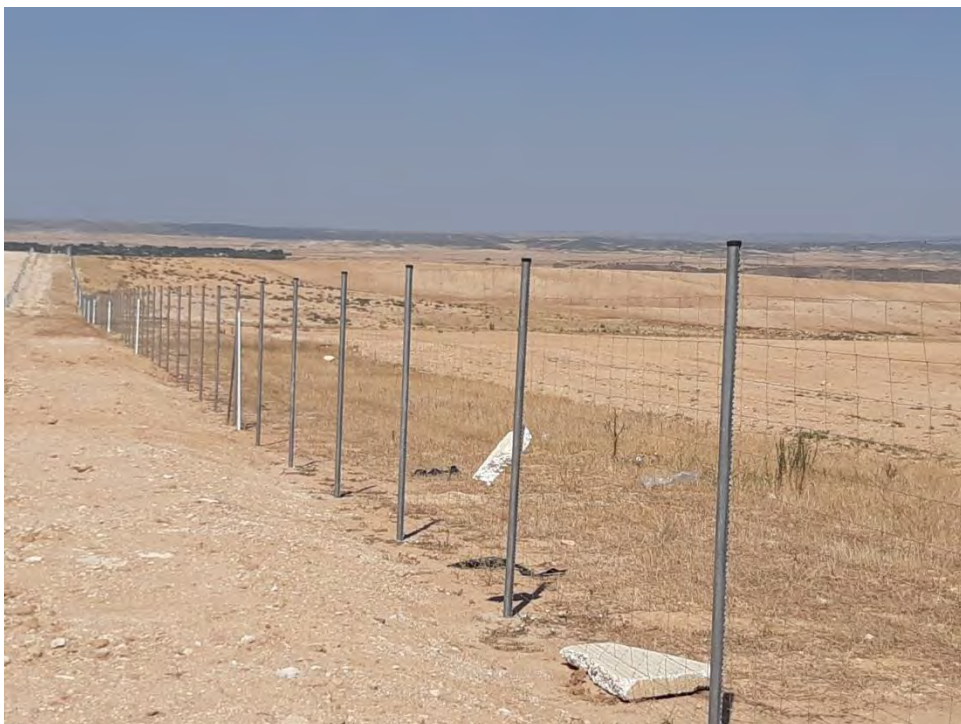
Fig. 3 Residuos en perímetro del vallado
