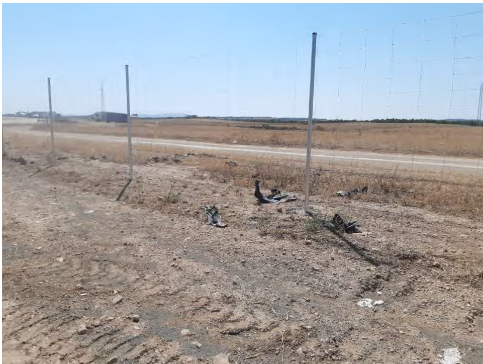
Fig. 1 Residuos en perímetro del vallado
