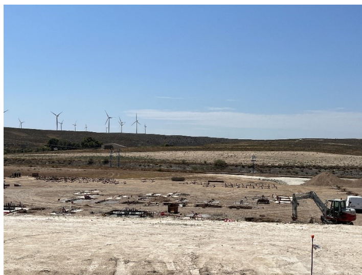
Figura 2 Excavación CS Ave
