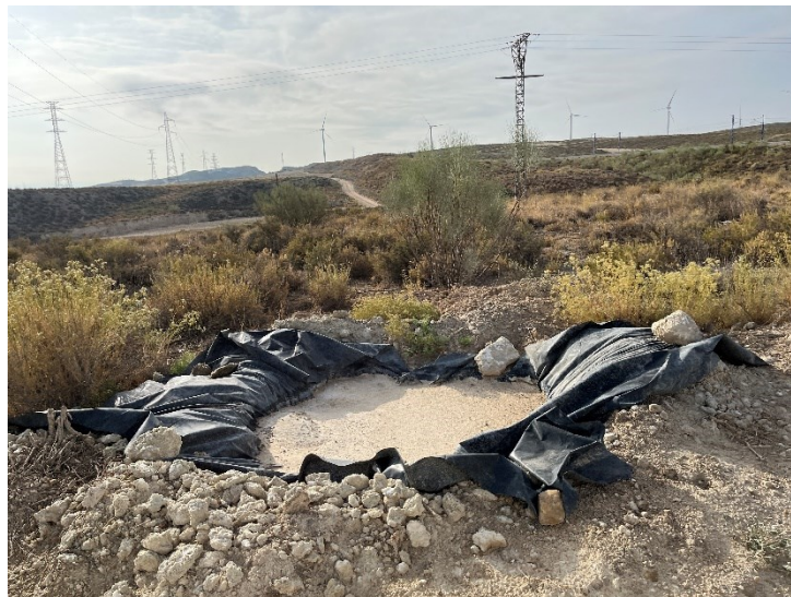
Figura 5 Lavadero de cubas de CS Ave
