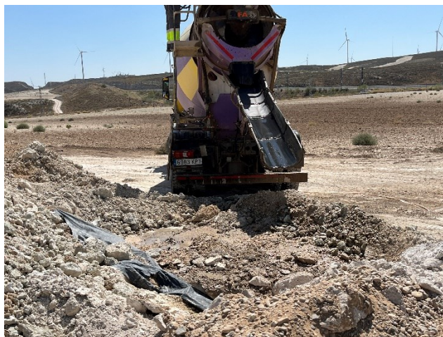
Figura 3 Limpieza de la cuba de hormigón
