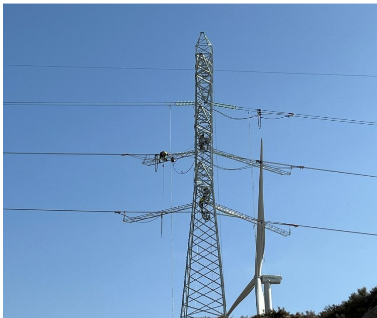
Figura 7 Fijación del cable
