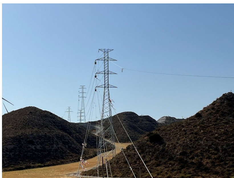
Figura 8 Tirada de cable Ap. 14 a 20
