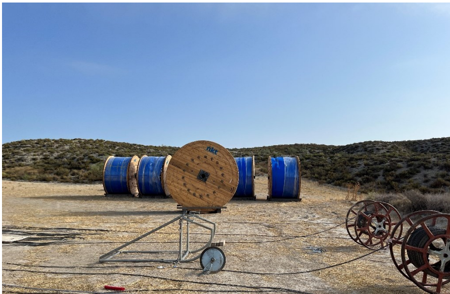
Figura 6 Acopio del cable de alta tensión
