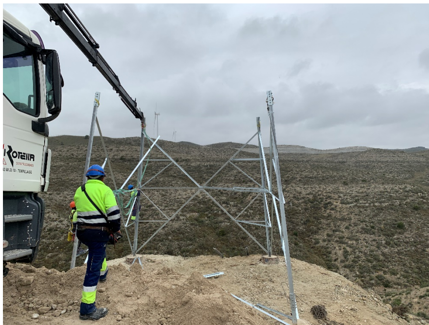
Figura 7 Montaje estructura apoyo 4
