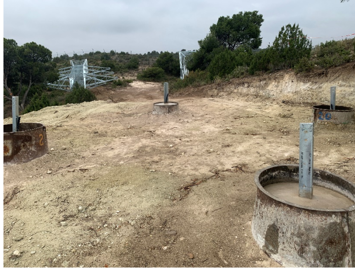
Figura 3 Cimentación de los apoyos
