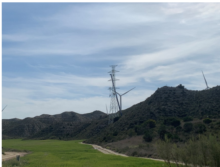
Figura 4 Izado del apoyo
