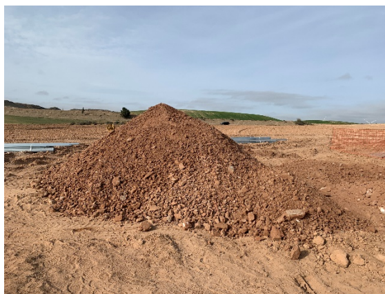
Figura 5 Acopio de tierra vegetal
