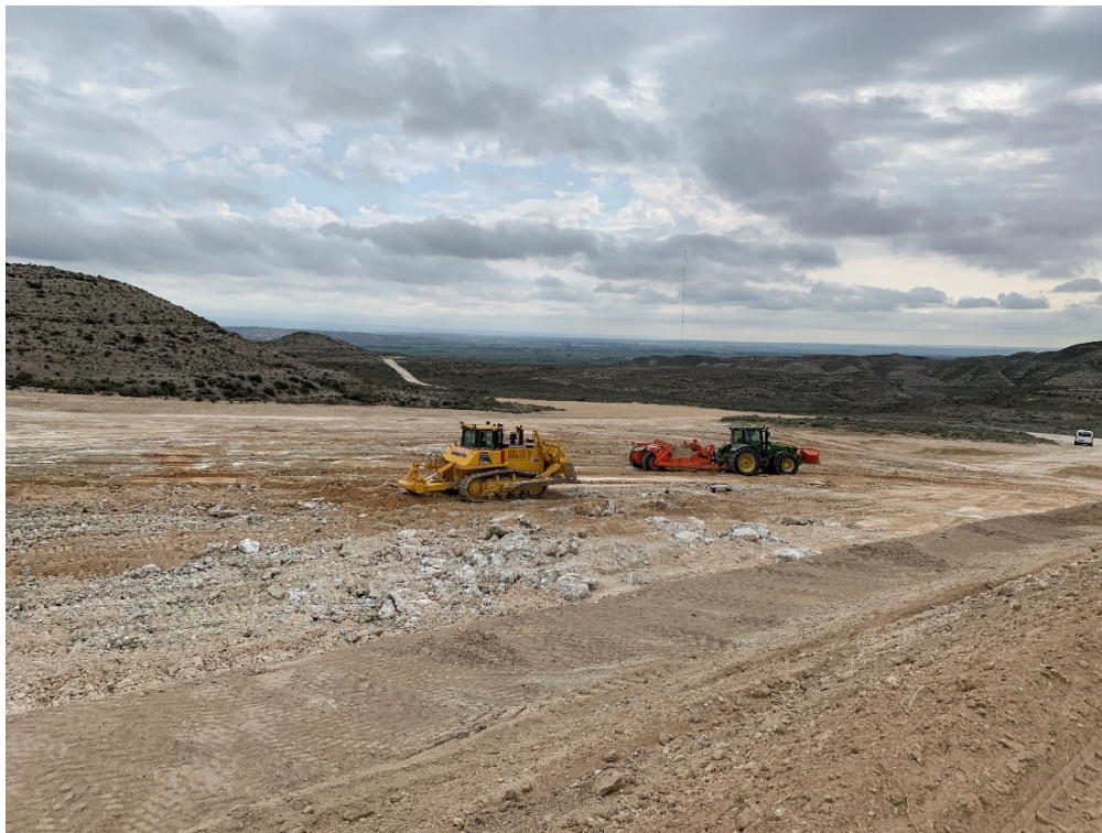
Figura 9 Movimientos de tierras de la SET
