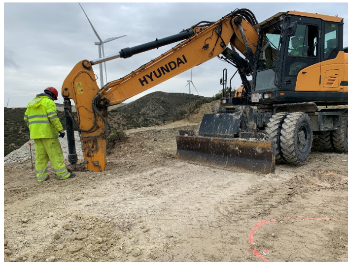
Figura 2 Excavación de los cimientos del apoyo
