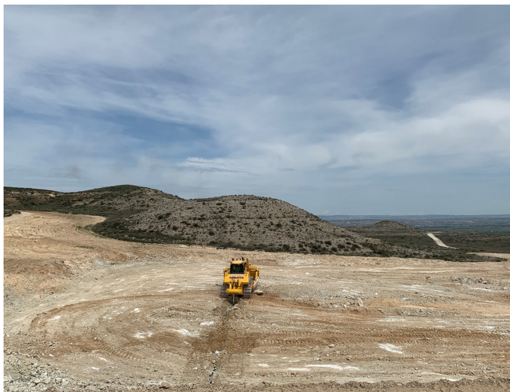
Figura 10 Movimientos de tierras en la SET
