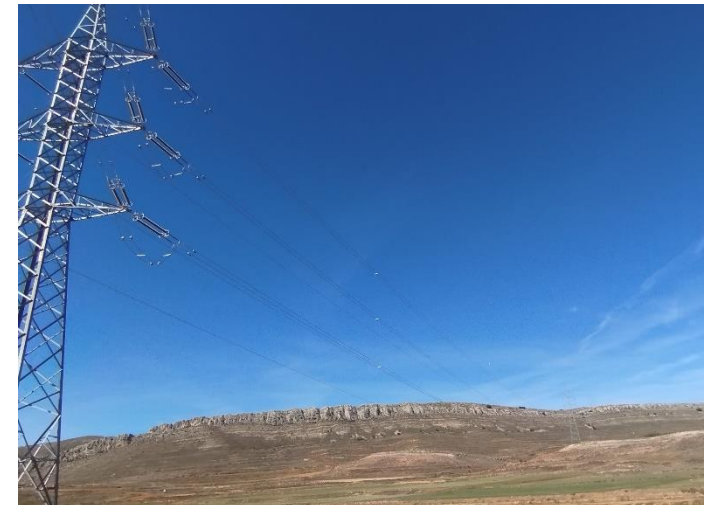
Fotografías 5 a 8: Apoyos de celosía y tendido con salvapájaros
