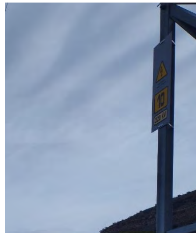
Fotografía 9: Señalización en apoyo
