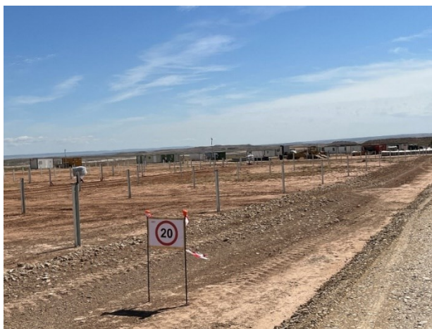
Figura 3 Señalización en obra
