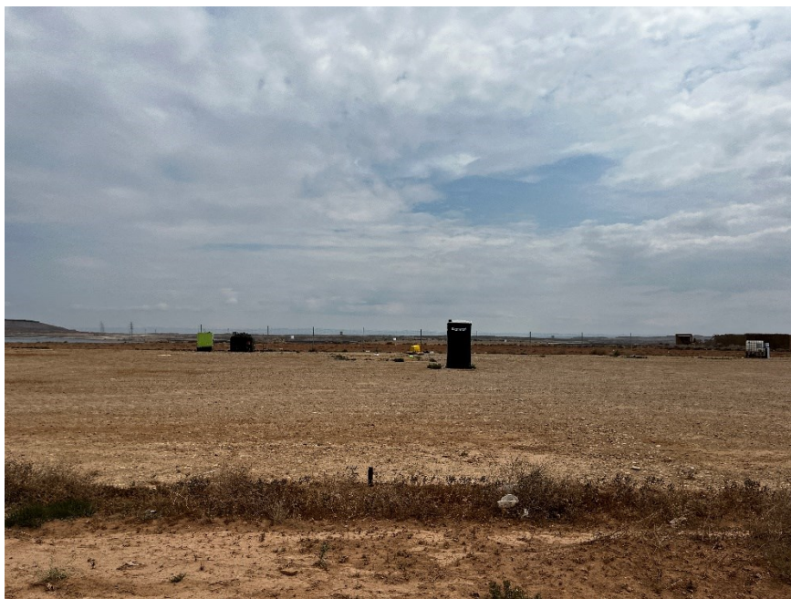
Figura 4 Desmantelamiento de la zona de casetas
