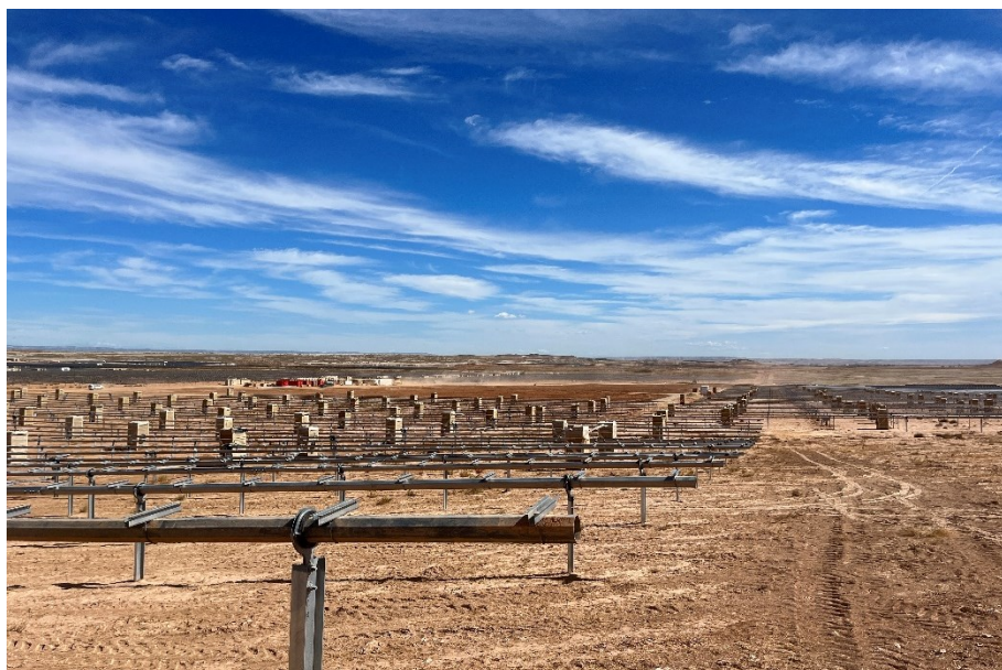
Figura 5 Montaje de los trackers
