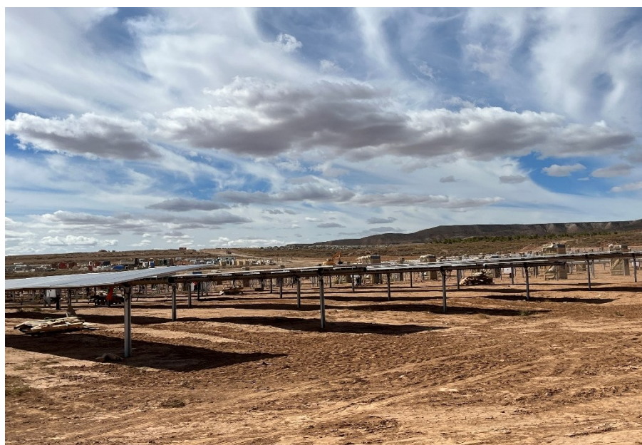
Figura 6 Montaje de los módulos
