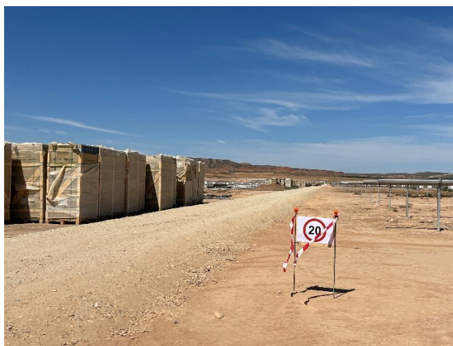
Figura 6 Señalización en obra
