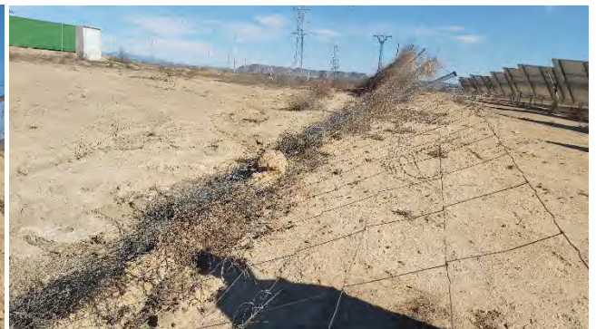
Figura 46: Vallado derrumbado (17/02/2022)
