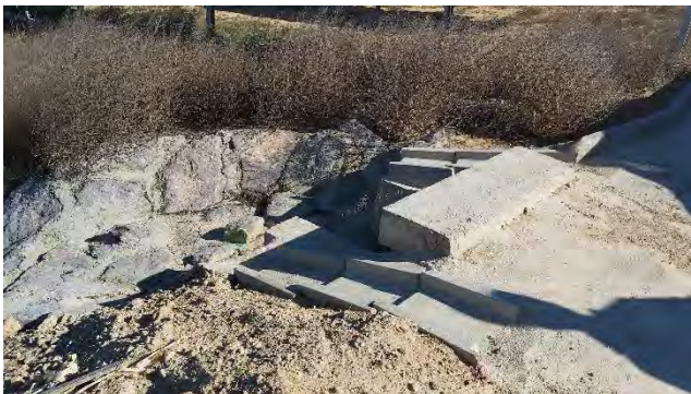
Figura 38: Bajante de agua en planta
