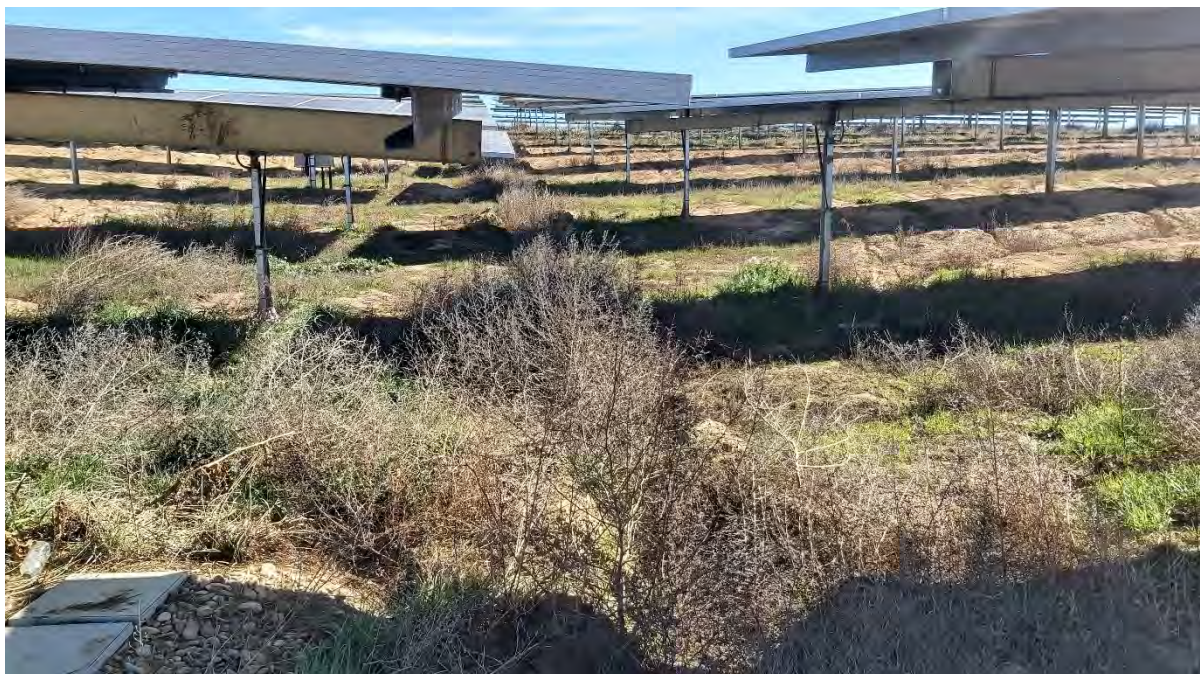
Figura 41: Vegetación existente en la planta en la visita 17/02/2022
