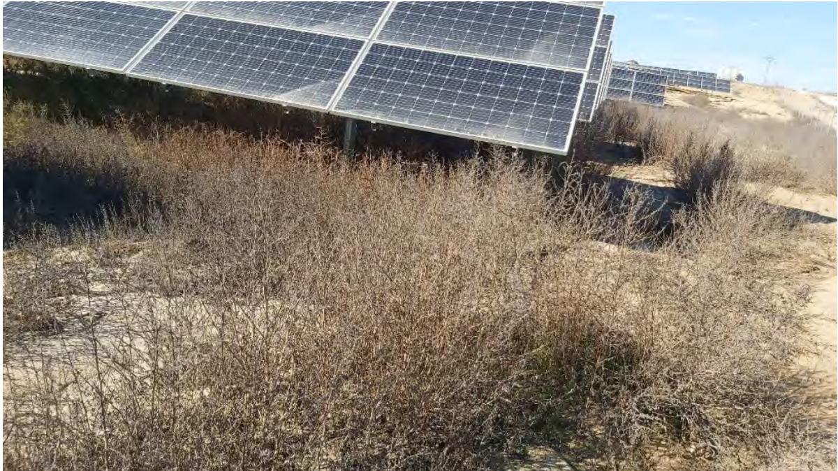
Figura 40: Vegetación existente en la planta en la visita 17/02/2022
