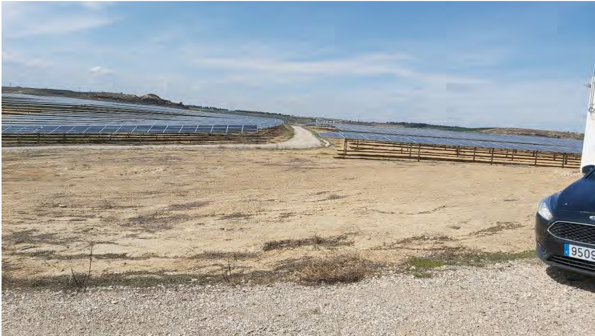
Figura 44: Desbroce mecánico realizado en zona de entrada a planta
