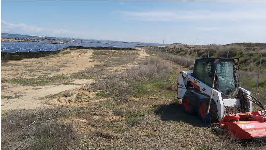
Figura 42: Desbroce mecánico en interior de vallado
