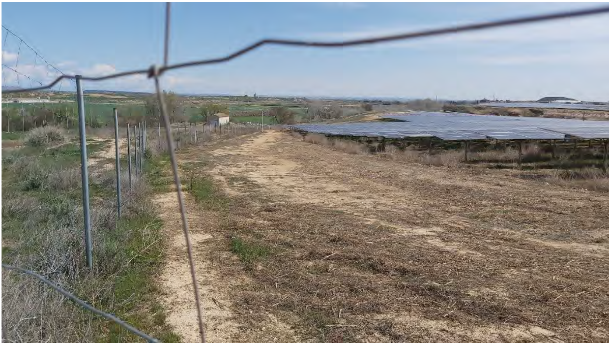
Figura 43: Desbroce mecánico realizado en zona cercana a vallado
