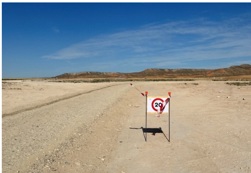
Figura 3 Señalización en obra
