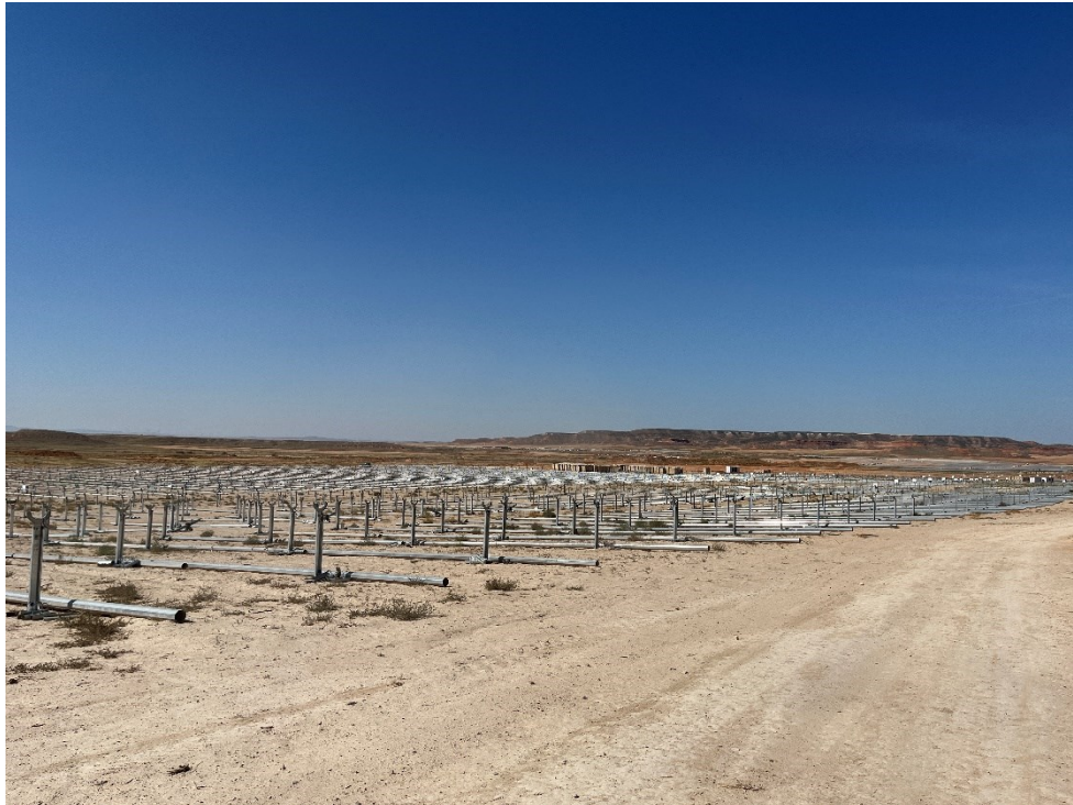
Figura 9 Vista general de la planta
