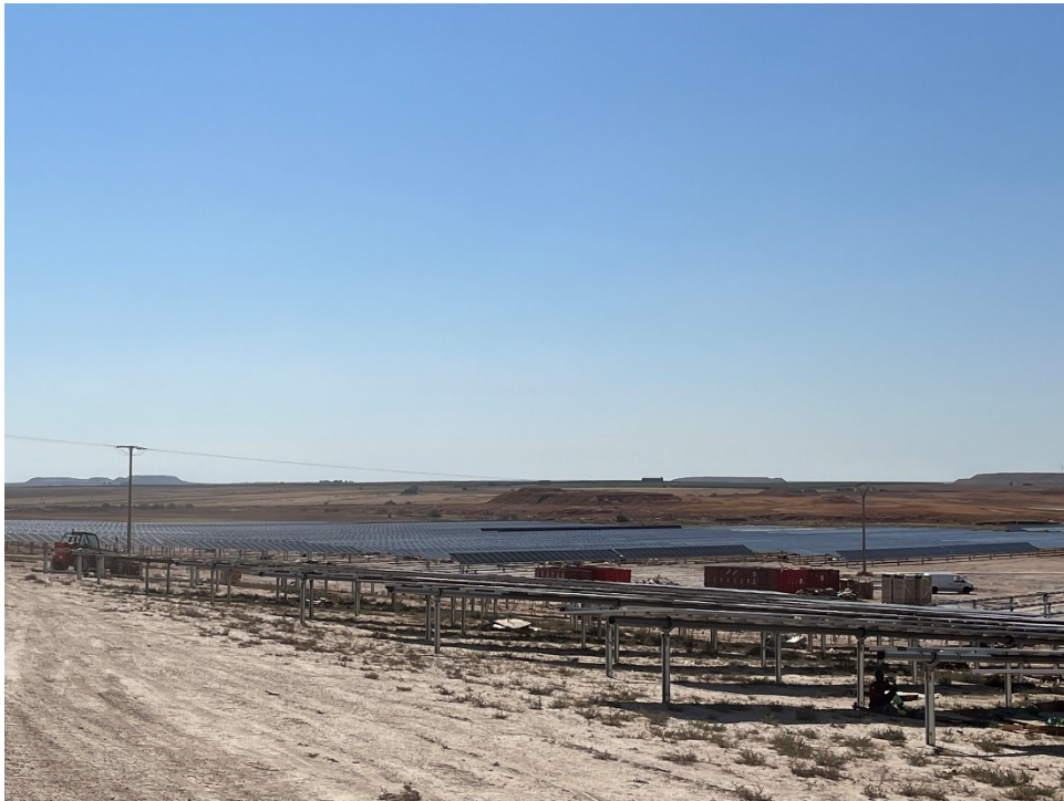
Figura 8 Vista general de la planta
