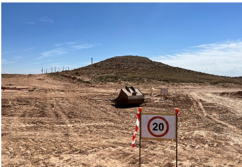
Figura 5 Señalización en obra
