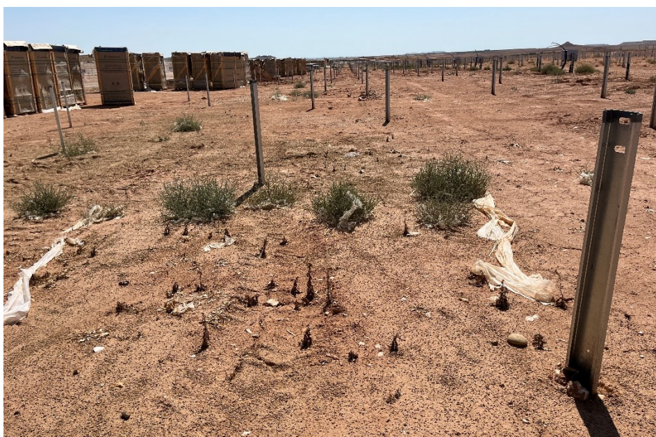
Figura 7 Restos de plásticos en el interior de la planta
