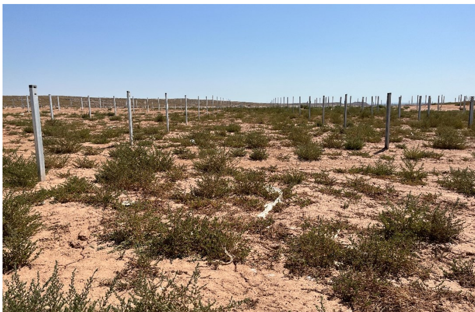
Figura 6 Restos de plásticos en el interior de la planta
