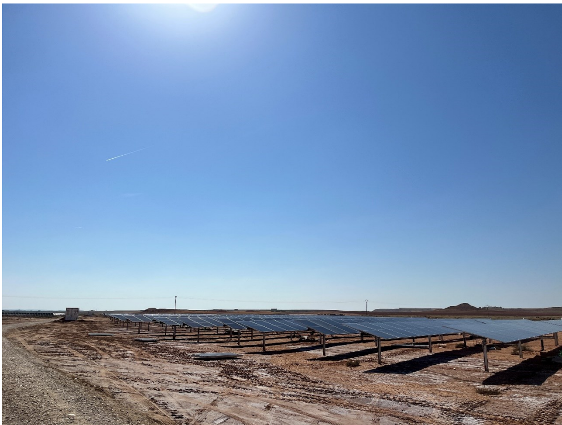
Figura 2 Montaje de los módulos fotovoltaicos
