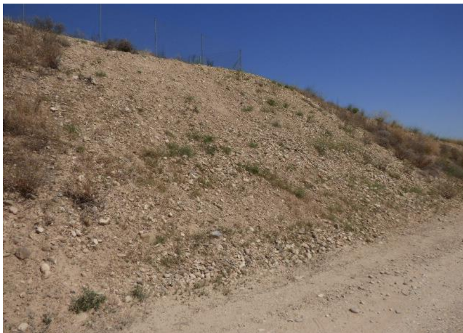
Imagen 1: La nascencia de las semillas hidrosebradas en el talud exterior, situado al Noroeste de la planta fotovoltaica, es irregular, es necesario esperar a las precipitaciones de otoño para verificar el resultado real de la hidrosiembra. A fecha de redacción del presente informe, no se observan procesos erosivos en dicho talud
