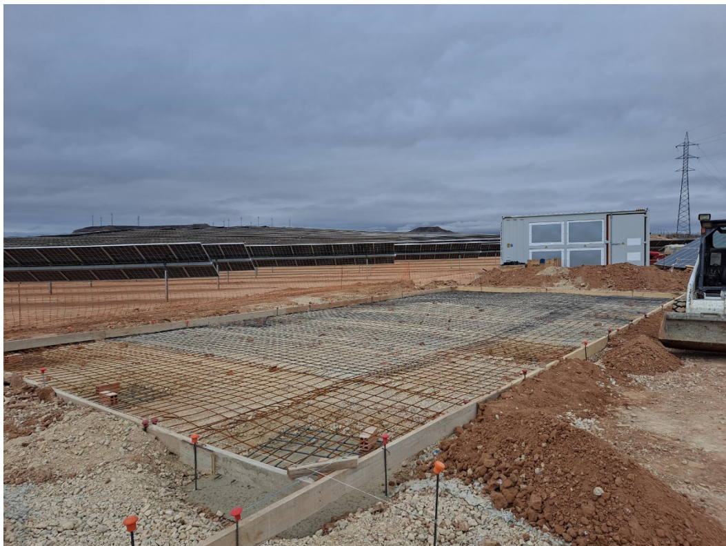
Foto 2. Detalle de la solera de hormigón del futuro almacén
