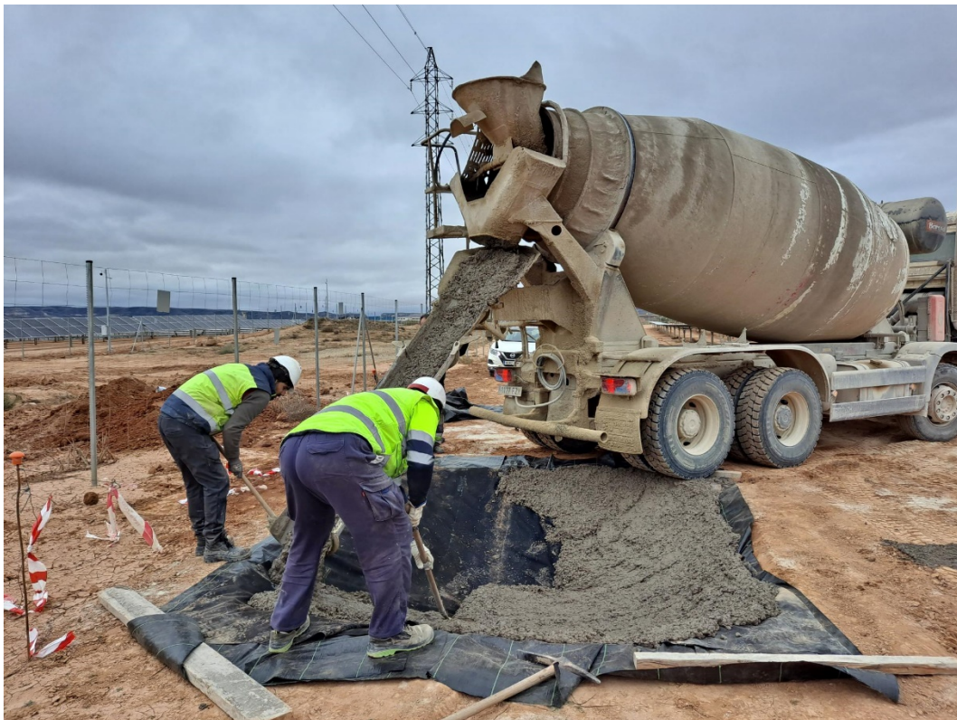
Foto 6. Lámina impermeable e impermeabilización de la balsa
