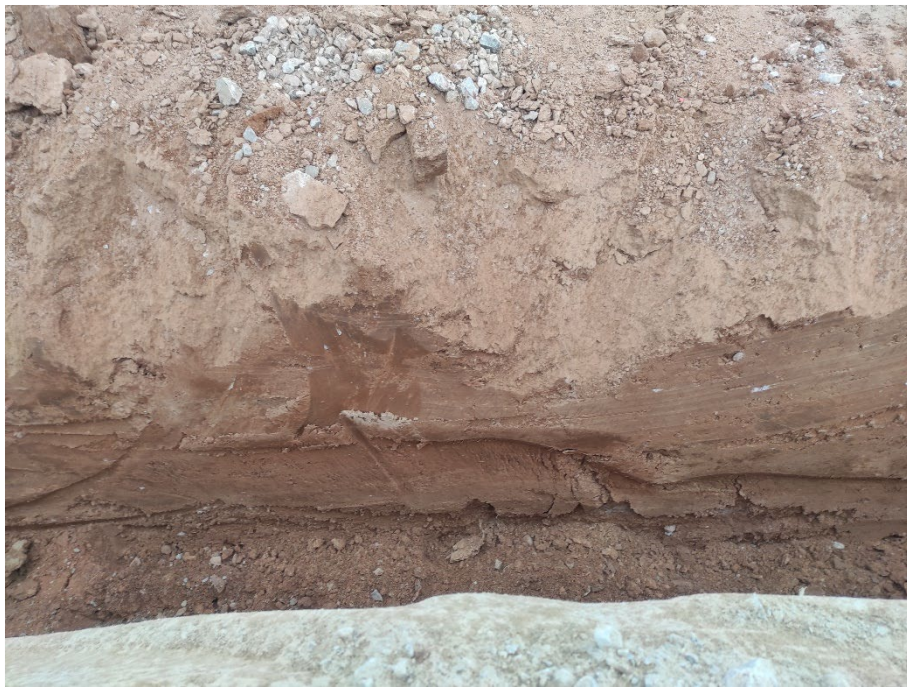
Fot 3. Perfil de la zanja de evacuación.
