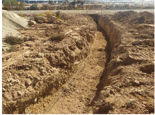
Fot 1 y 2. Ejecución de la zanja de evacuación de MT y BT en Pitarco B1 y B2.
