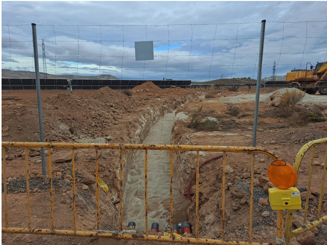
Foto 10. Cama de arenado en fondo de zanjas
