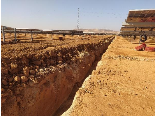
Fot 1 y 2. Ejecución de la zanja de evacuación de MT y BT en Pitarco B1 y B2.
