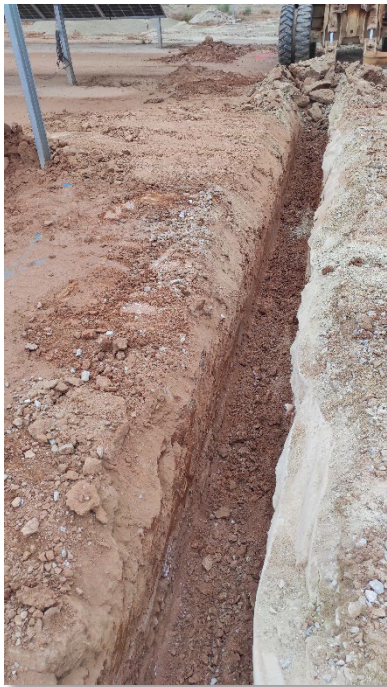
Fot 1 y 2. Ejecución de la zanja de evacuación de MT y BT en Pitarco B1 y B2.
