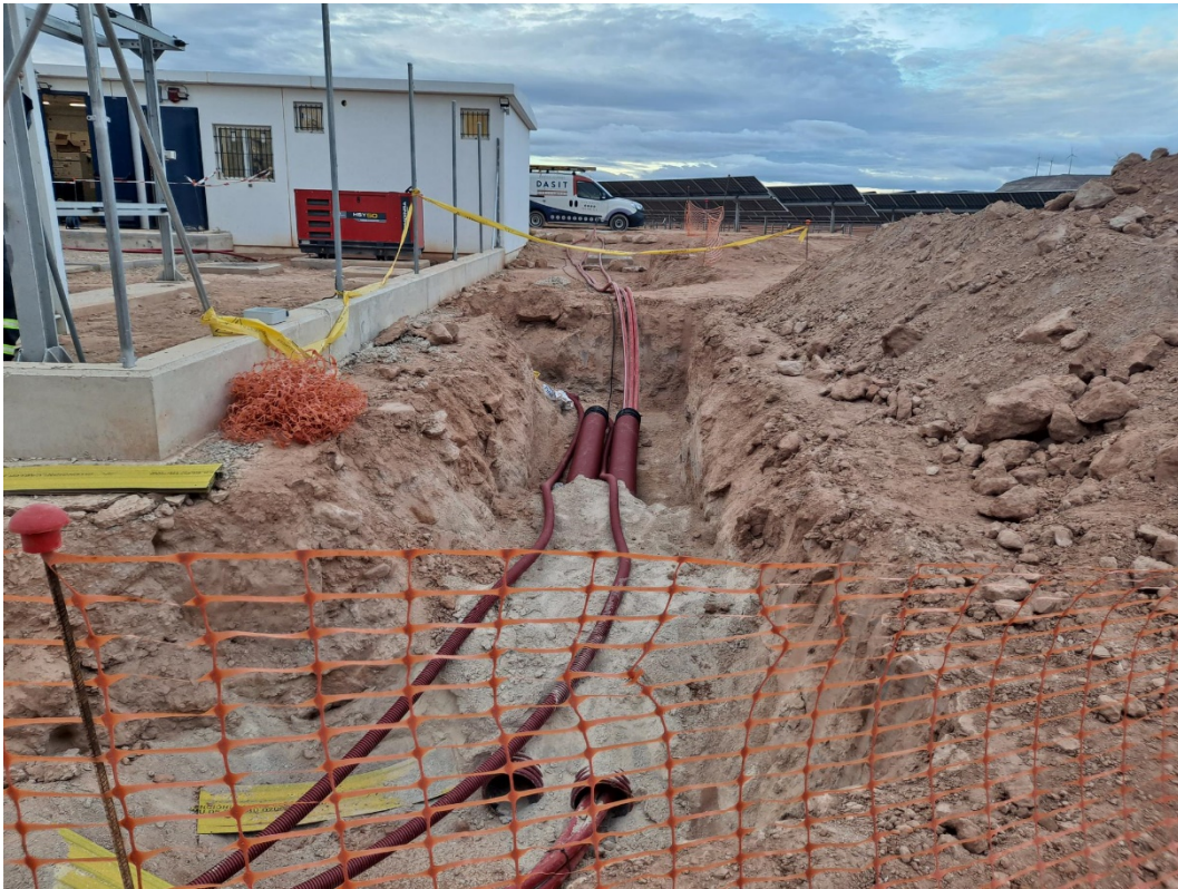
Foto 6. Apertura de zanjas e instalación de cableado SET
