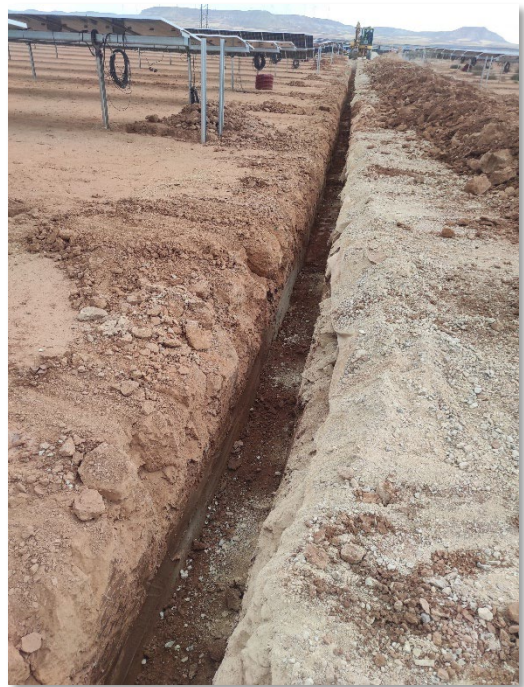
Fot 1 y 2. Ejecución de la zanja de evacuación de MT y BT en Pitarco B1 y B2.
