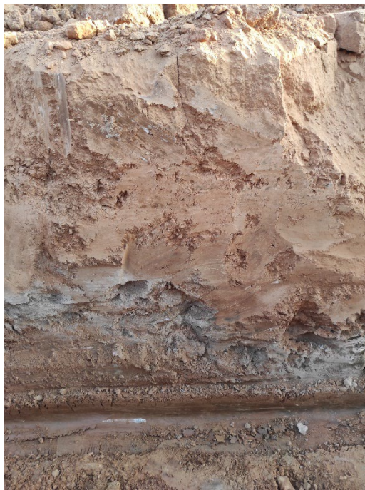
Fot 3. Perfil de la zanja de evacuación.
