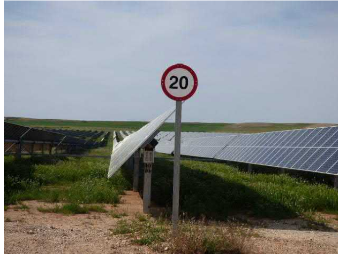
Imagen 5: Señal de límite de velocidad situada en uno de los viales del parque fotovoltaico.
