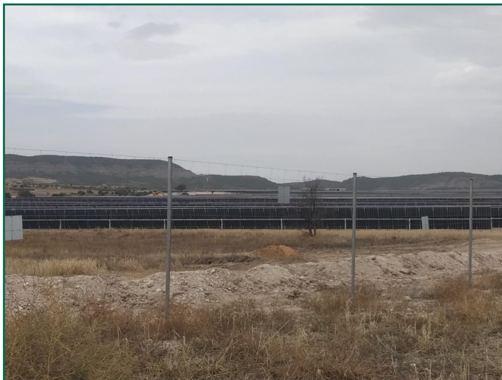
Fotografía 6. Vallado perimetral con placas anticolidión.
