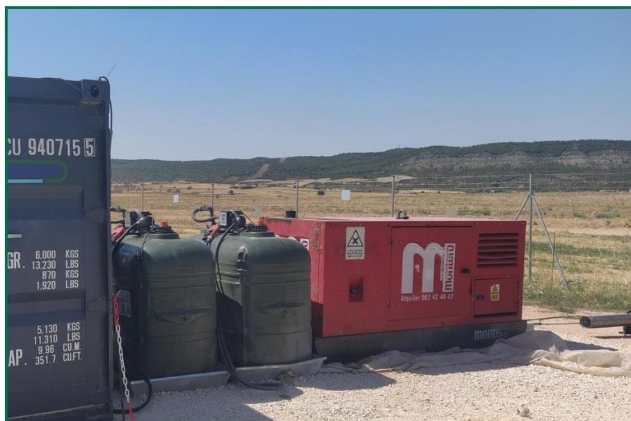
Fotografía 16. Bandejas para evitar derrames accidentales sobre el terreno.
