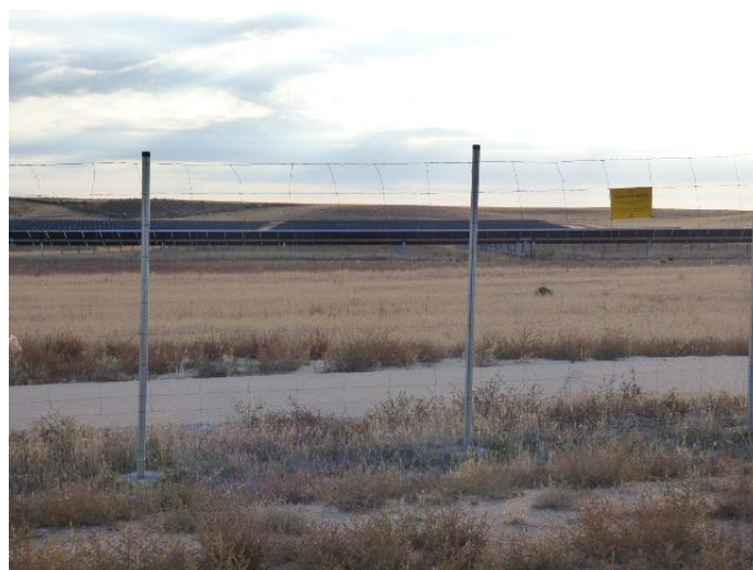
Imágenes 11, 12 y 13: Acumulación de Salosa kali en el vallado perimetral (izquierda y derecha). Vallado perimetral limpio de Salosa kali tras la aplicación de las medidas de mantenimiento (abajo).
