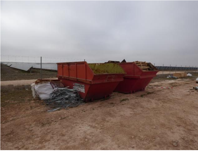
Imágenes 26 y 27: Contenedor de residuos no peligrosos sin etiquetado correspondiente (izquierda). Residuos de obra depositados fuera de los contenedores habilitados (derecha).
