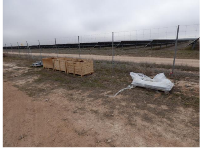
Imágenes 26 y 27: Contenedor de residuos no peligrosos sin etiquetado correspondiente (izquierda). Residuos de obra depositados fuera de los contenedores habilitados (derecha).
