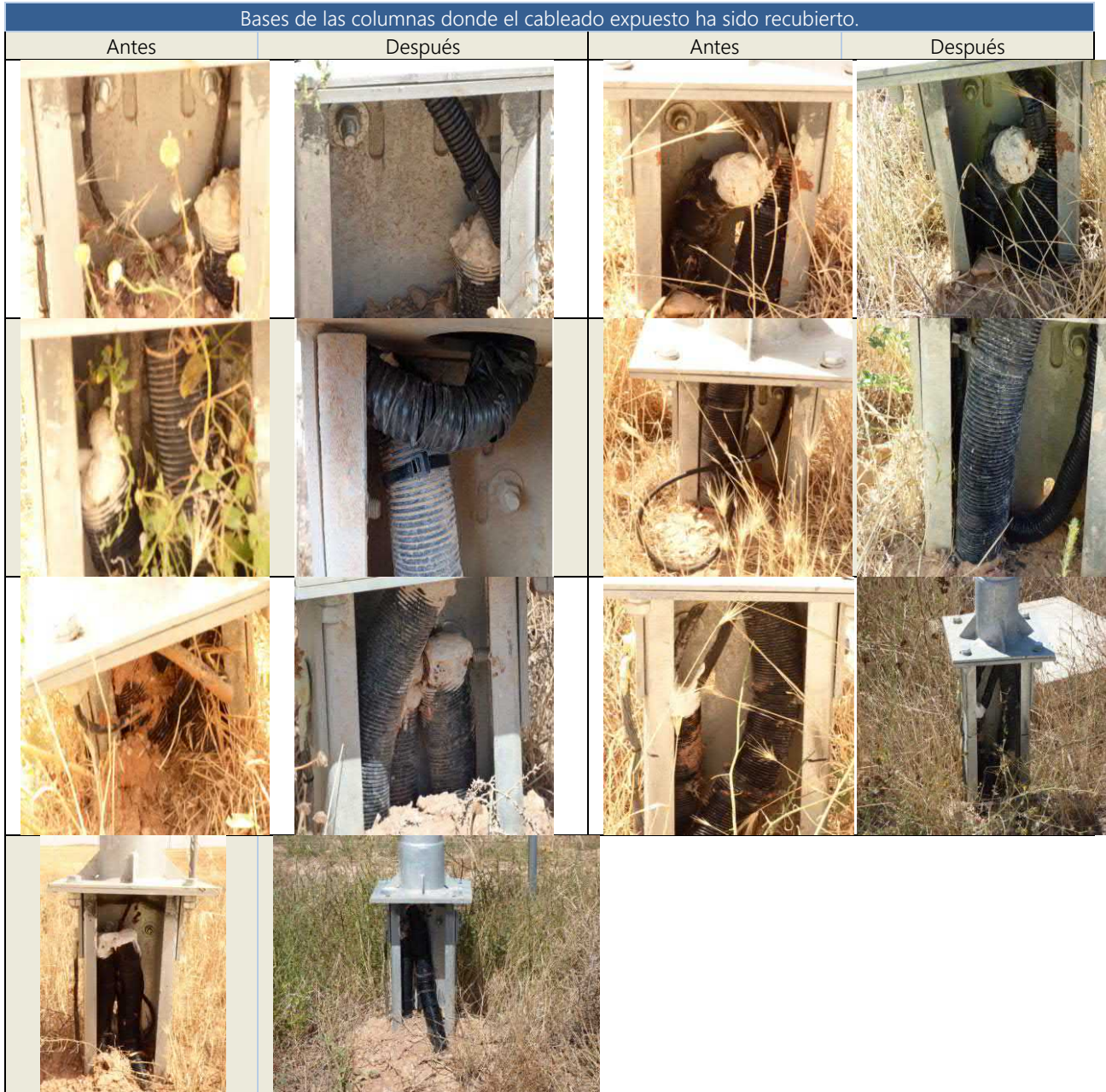
Imágenes 9, 10, 11, 12,13, 14, 15, 16, 17, 18, 19, 20, 21y 22: bases de las columnas antes y después de la protección del cableado
