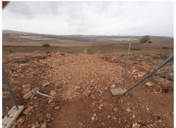
Fig. 2 Estado actual de zanja con excedentes de excavación con piedra triturada
