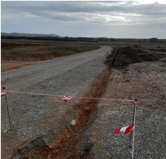
Fig. 1 Cuneta abierta para el paso de agua en acceso a SET Escucha
