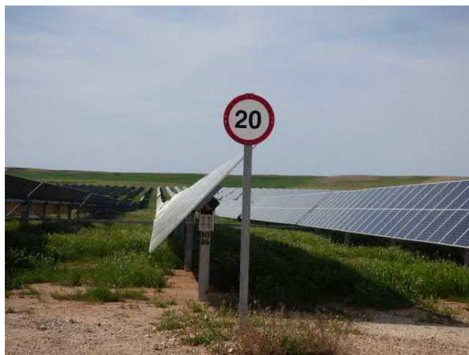
Imagen 9: Señal de límite de velocidad situada en el interior de los viales internos del parque fotovoltaico.
