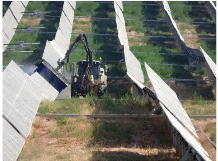
Imágenes 3 y 4: Extensión utilizada para la limpieza de paneles (izquierda). Tractor con la extensión adjunta, realizando la limpieza de paneles (derecha).
