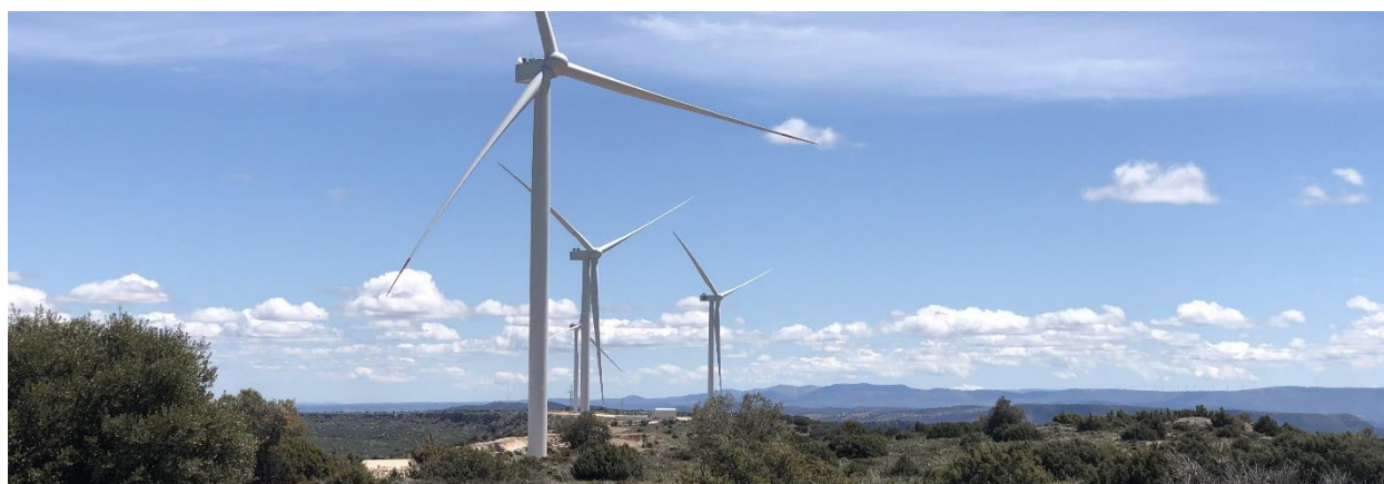
Figura 1: Vistas del parque eólico Oriche
