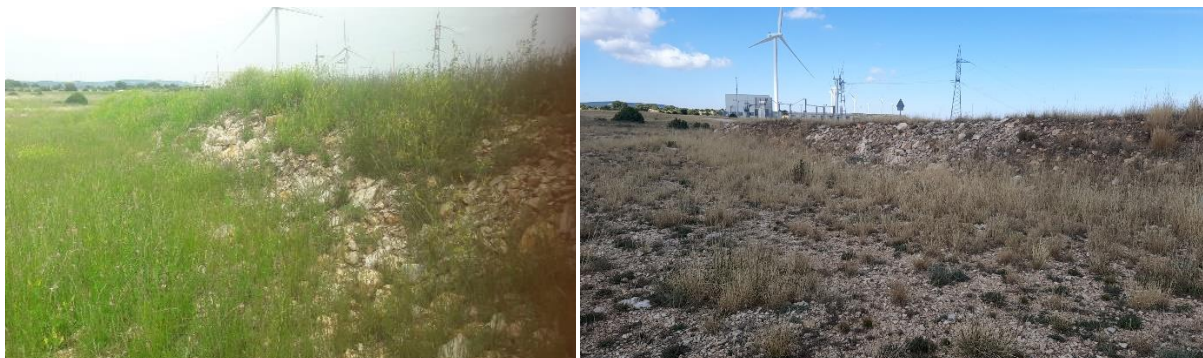
Comparativa del talud sur de SO-04 entre cuatrimestres anteriores (izquierda) y el cuatrimestre actual (derecha). La sequía estival ha afectado a la vegetación.
