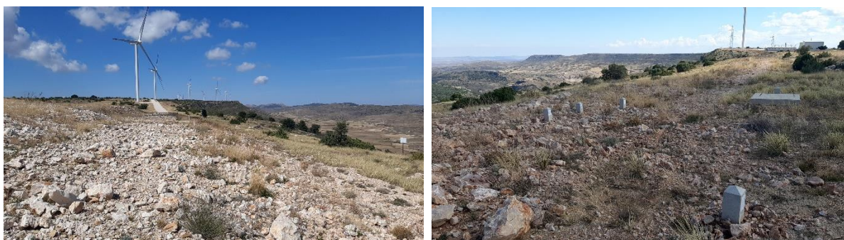
Zonas de cableado subterráneo en la cara norte de SO-02 y SO-03, respectivamente.
