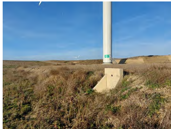
Fotografía 17: Estado obras de drenaje
