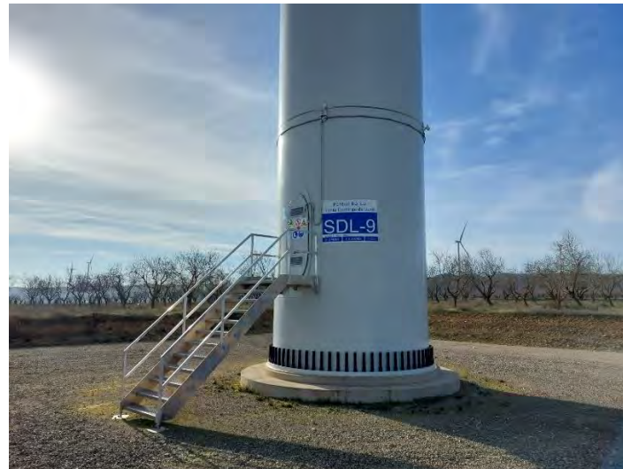
Fotografías 12 a 14: Señalización de las torres de los aerogeneradores
