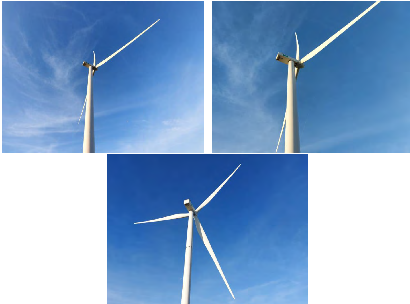
Fotografías 5 a 7: Barquillas de los aerogeneradores sin derrames de aceite
